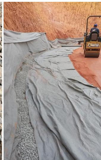
Figuras 21 e 22 - Execução do solo reforçado com geogrelha, execução de dreno de brita
