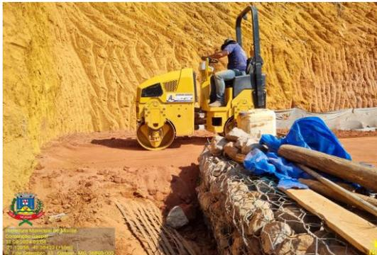
Figuras 15 e 16 - Execução do solo reforçado com geogrelha, execução de aterro com compactação mecanizada
