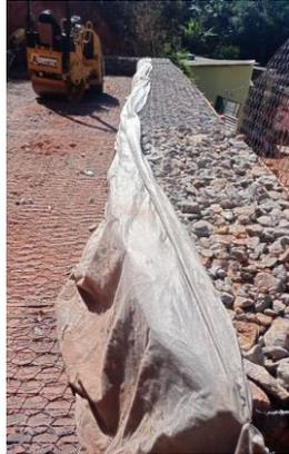
Figuras 1, 2 e 3 - Execução do solo reforçado com geotêxte, execução de filtro de brita e isolamento do gabião com geotêxte
