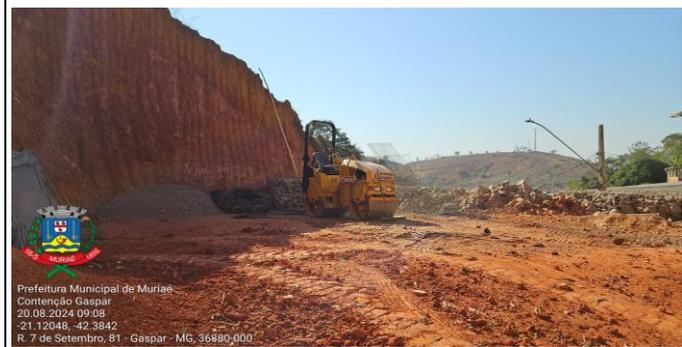
Figuras 11, 12 - Execução do solo reforçado com geogrelha
