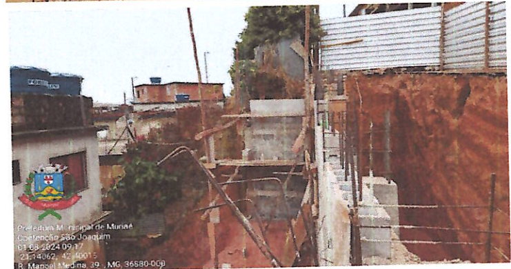
Figura 03 - Formas, armação e concretagem de pilares e vigas. Alvenaria preenchida de concreto e aço. Chumbamento com resina epoxi.
