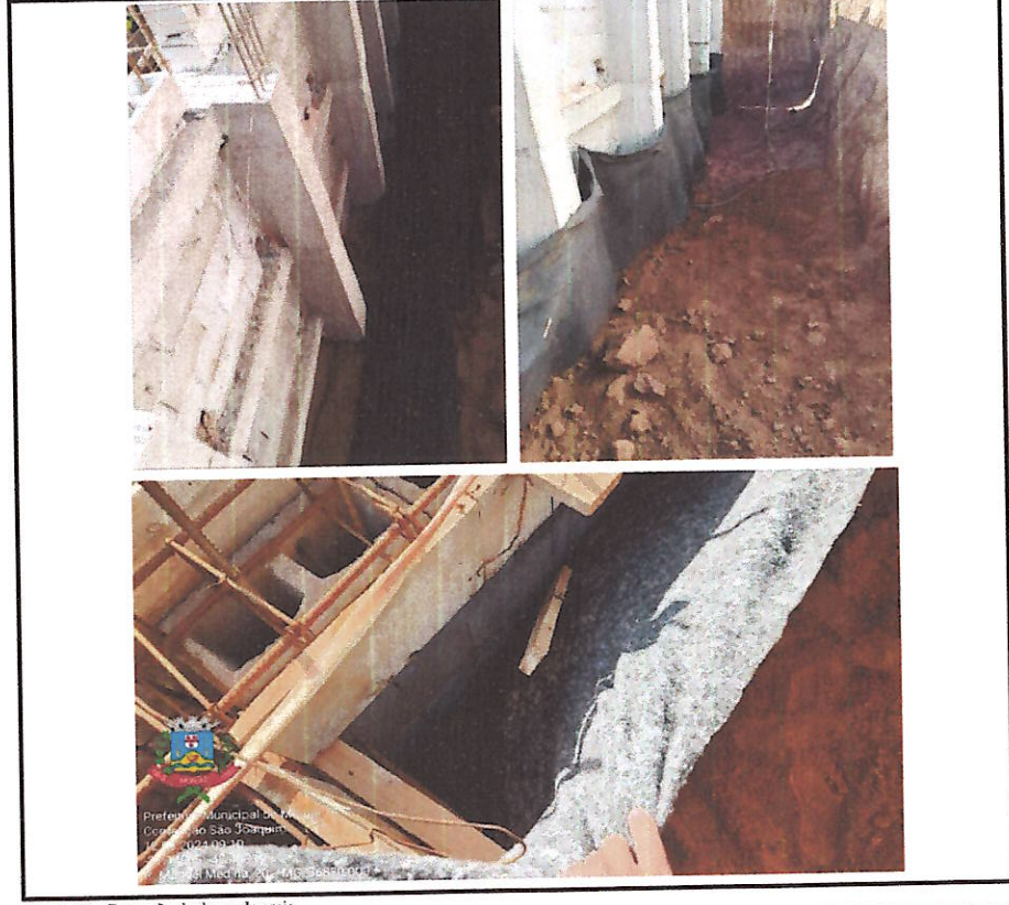
Figura 06 - Execução de dreno de areia.
