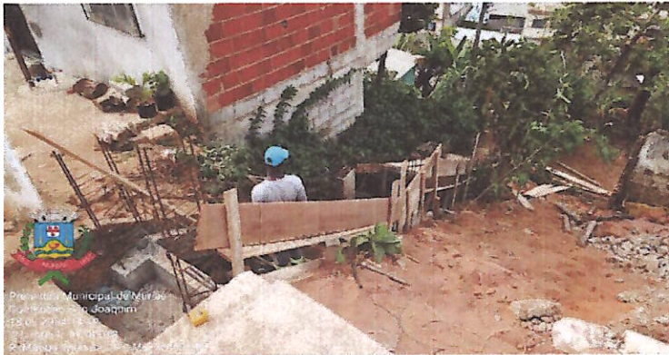
Figura 13 - Execução de estrutura de escada (baldrames e pilares)
