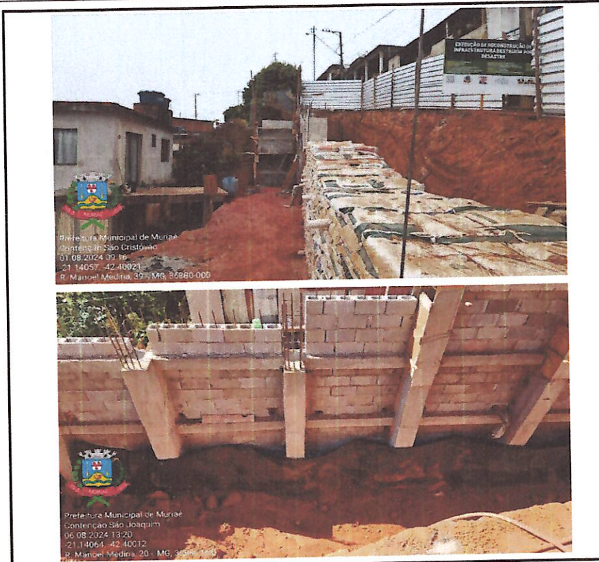
Figura 05 - Reaterro a montante das contenções.
