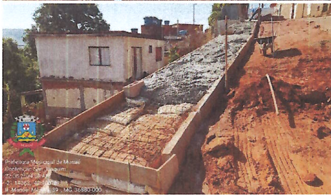
Figura 11 - Assentamento de meio-fio e concretagem de calçada armada
