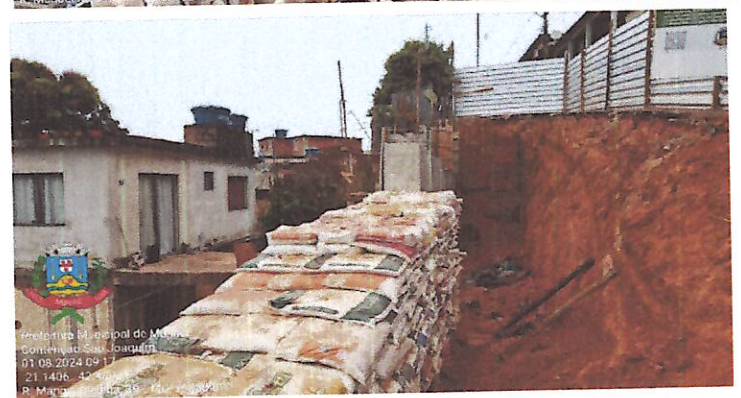
Figura 04 - Contenção em solo-cimento ensacado (rip-rap)
