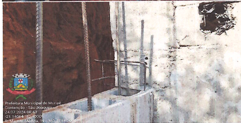
Figura 01 - Formas, armação e concretagem de pilares e vigas. Alvenaria preenchida de concreto e aço. Clumbamento com resina epoxi.
