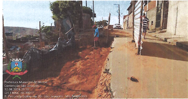
Figura 08 - Reaterro a montante das contenções.
