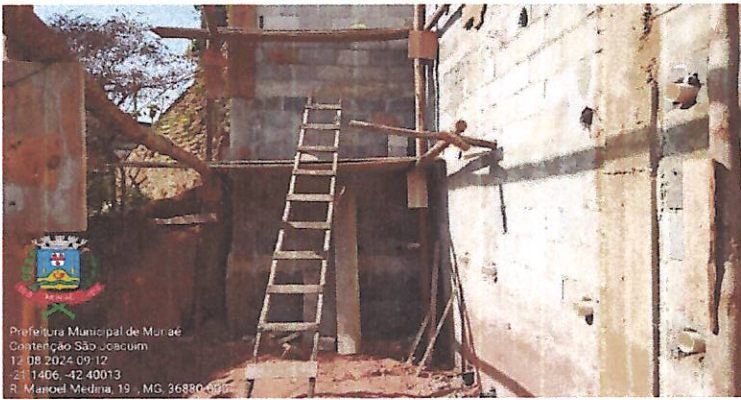
Figura 07 - Reaterro a montante das contenções.
