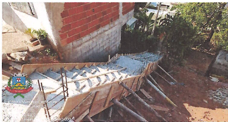
Figura 15 - Fabricação de formas e concretagem de lances e patamares de escadas
