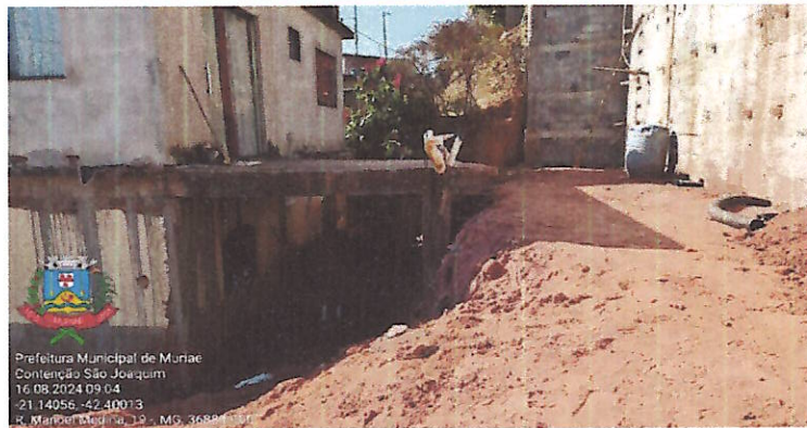
Figura 09 - Desaterro manual, carga e transporte de solo em carrinho.
