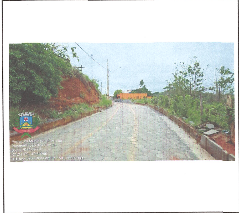
Figura 10 - Pavimento rejuntado e sarjetas "tipo A"
