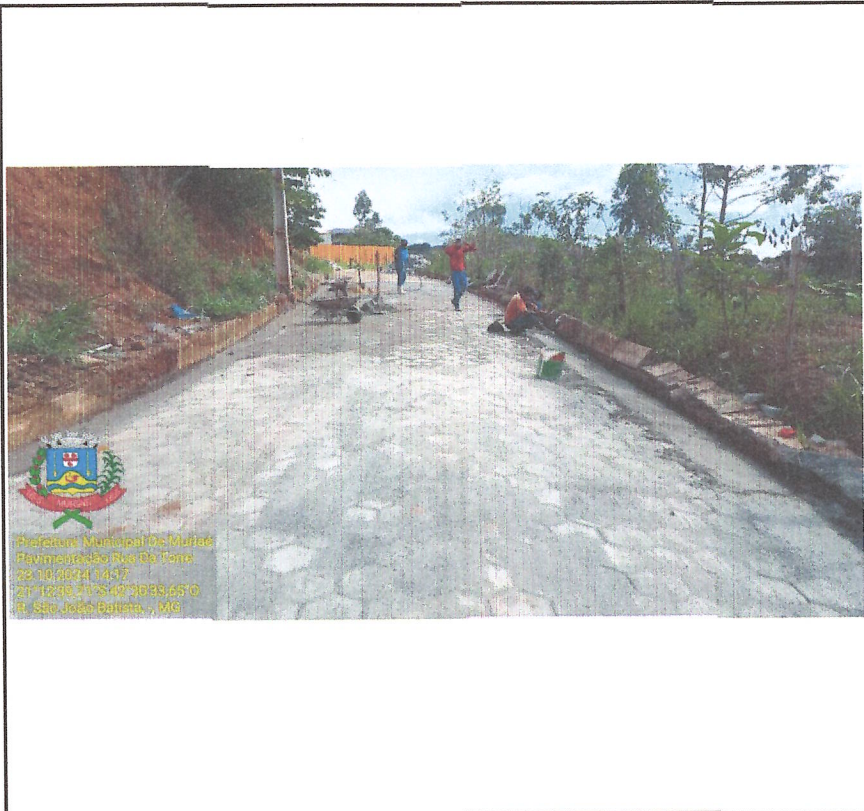
Figura 09 - Pavimento rejuntado e sarjetas "tipo A"
