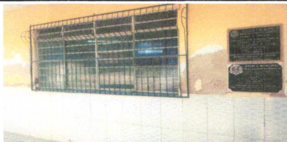
IMAGEM 2: PAREDE FACHADA LOCAL: E.M. MARIA HASTENREITER
