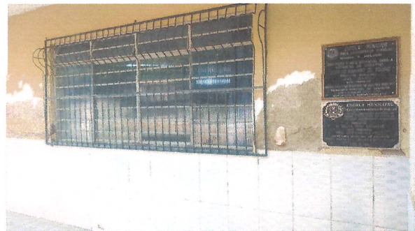
IMAGEM 2: PAREDE FACHADA LOCAL: E.M. MARIA HASTENREITER
