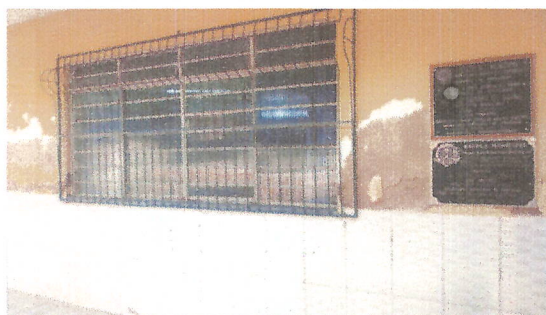
IMAGEM 2: PAREDE FACHADA LOCAL: E.M. MARIA HASTENREITER
