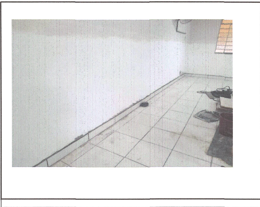
Foto 14: INSTALAÇÃO DE RODAPÉ EM SALAS
