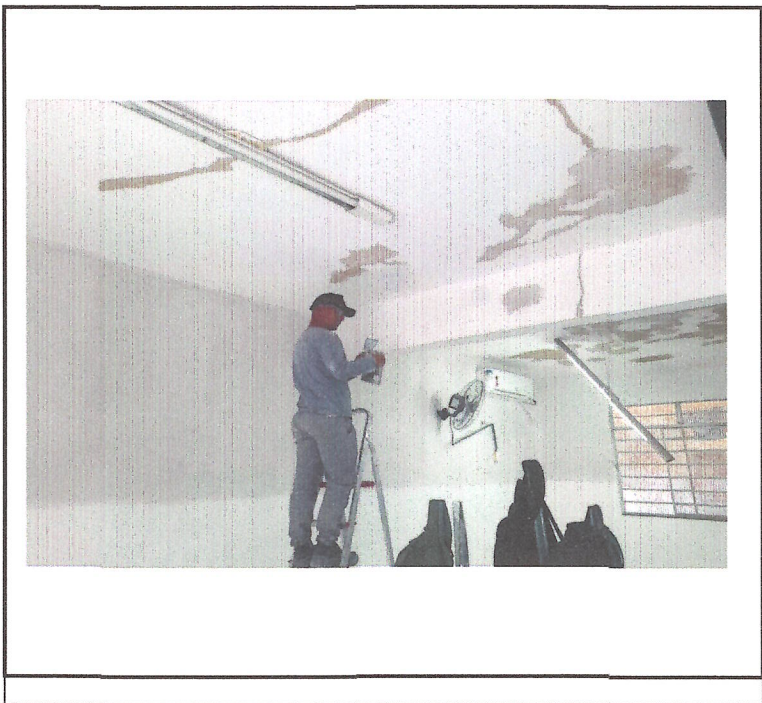
Foto 13: LIXAMENTO E PREPARAÇÃO DE PINTURA NO TETO
