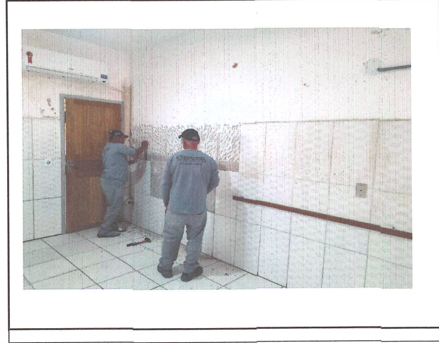
Foto 2: REMOÇÃO DE CERÂMICAS
