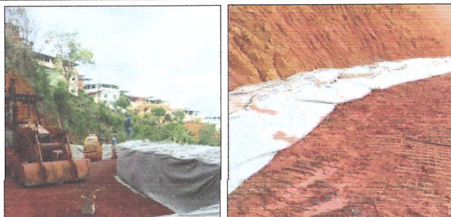
Figuras 16, 17 e 18 - colocação de geotêxtil e armação da gasôla
