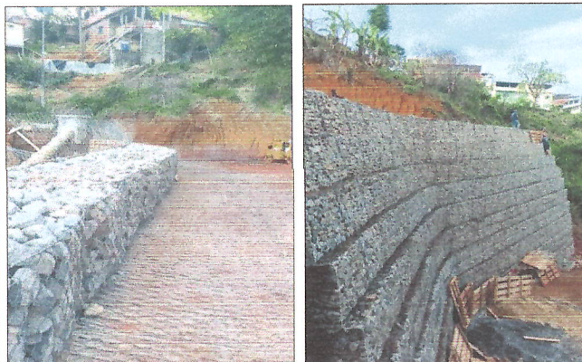
Figuras 19, 20 e 21 - geotêxtil, preenchimento das gasôlas
