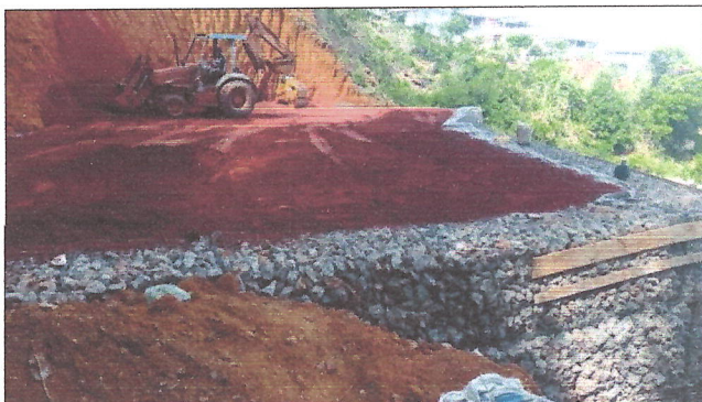
Figuras 14 e 15 - Execução atenu com compactação mecanizada
