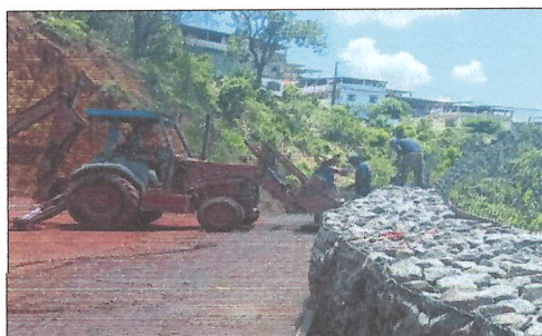
Figuras 14 e 15 - Execução atenu com compactação mecanizada
