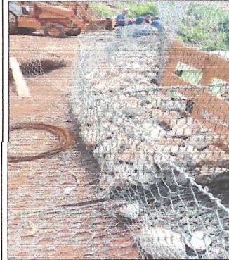
Figuras 5, 6, 7 e 8 - fixação e preenchimento das galoas, execução de dreno de brita
