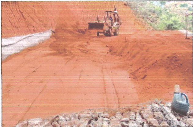
Figuras 9 e 10 - preenchimento das galoas e execução aterro com compactação mecanizada
