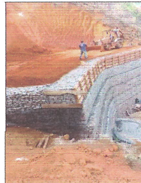
Figuras 5, 6, 7 e 8 - fixação e preenchimento das galoas, execução de dreno de brita
