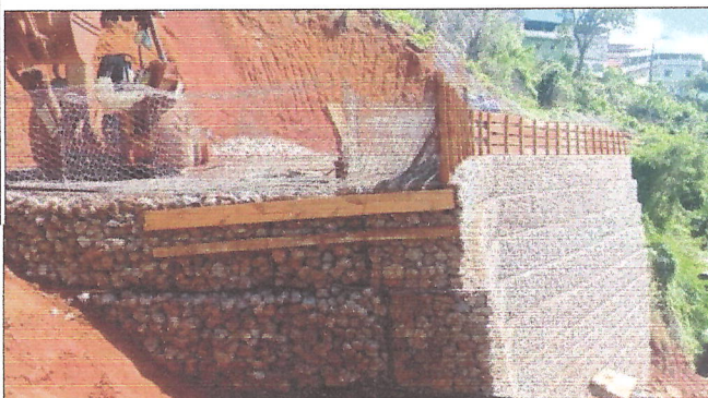
Figuras 16, 17 e 18 - colocação de geotêxtil e armação da gasôla
