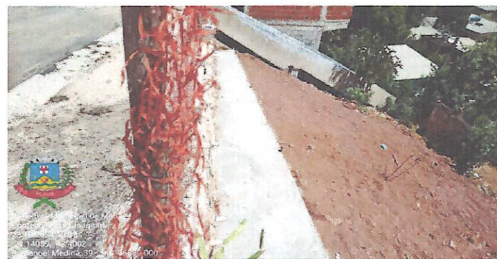
Figura 03 e 04 - Construção de muro de divisões concreto armado e alvenaria de blocos preenchidos; proteção de talude em laje
