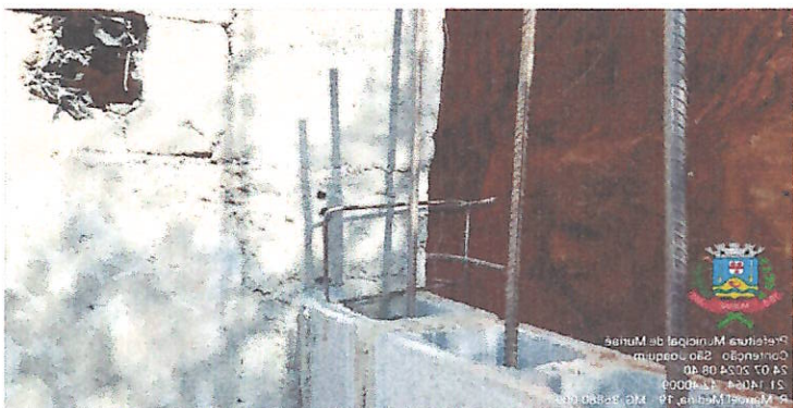
Figura 01 e 02 - Escavação para fundação de muro de divisa; furo para ancoragem
