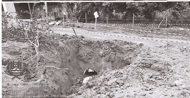
Figura 01 e 02 - Execução de pavimento sextavado e sarjeta em concreto; tubo de concreto assentado em vala e reaterroado
