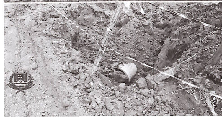
Figura 03 e 04 - Escavação de vala para assentamento de tubo de concreto e reaterro de vala
