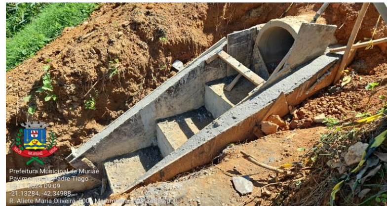
Figura 11 e 12 - Descidas hidráulicas e dissipadores
