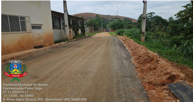
Figura 05 e 06 - Base de solo brita e execução de boca de lobo
