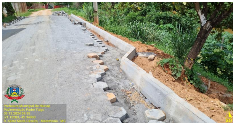
Figura 09 e 10 - Assentamento dos bloquetes sextavados
