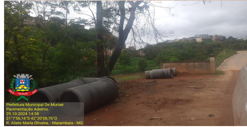
Figura 03 e 04 - Tubos de concreto d = 600mm para drenagem
