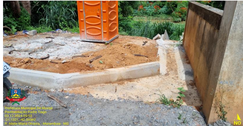
Figura 07 e 08 - Assentamento de meio-fio e sarjeta trapezoidal
