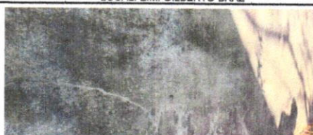
IMAGEM 4: ENCONTRO DE TELHADO COM ALVENARIA SEM MANTA LOCAL: E.M. GILBERTO BRAZ
