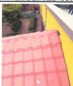
IMAGEM 4: ENCONTRO DE TELHADO COM ALVENARIA SEM MANTA LOCAL: E.M. GILBERTO BRAZ
