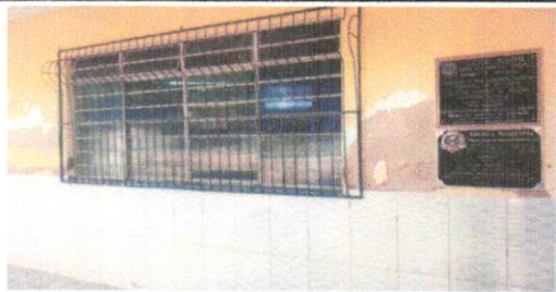
IMAGEM 2: PAREDE FACHADA LOCAL: E.M. MARIA HASTENREITER
