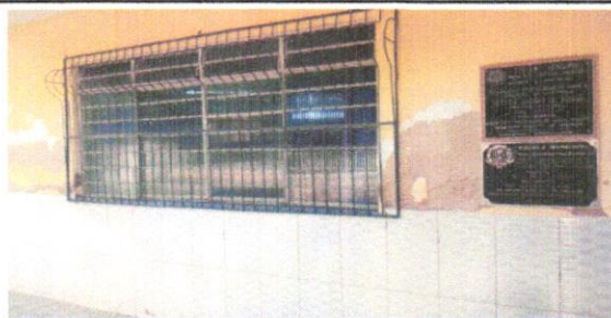
IMAGEM 2: PAREDE FACHADA LOCAL: E.M. MARIA HASTENREITER
