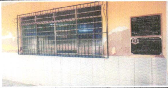
IMAGEM 2: PAREDE FACHADA LOCAL: E.M. MARIA HASTENREITER
