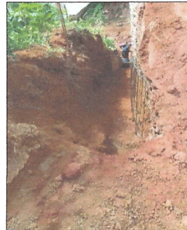
Figuras 4, 5, 6 e 7 - Aterro e compactação, e concretagem da escada hidráulica
