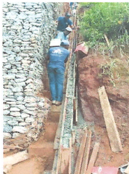
Figuras 11, 12, 13 e 14 - Armação e concretagem de escada hidráulica
