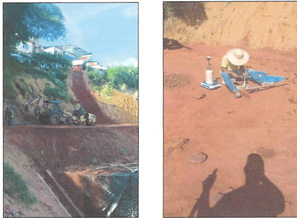
Figuras 15, 16 e 17: Aterro e compactação
