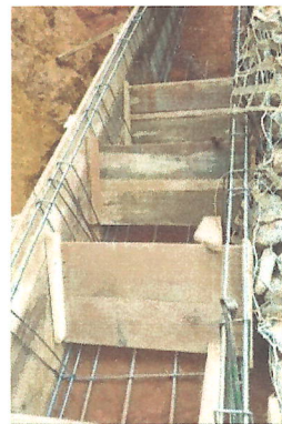
Figuras 4, 5, 6 e 7 - Aterro e compactação, e concretagem da escada hidráulica
