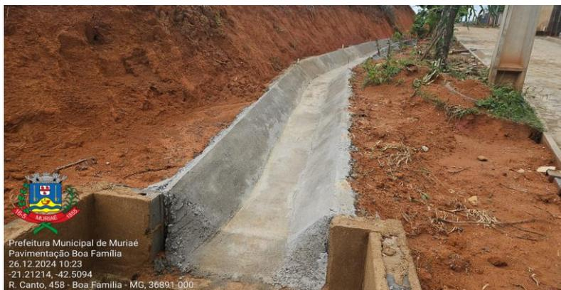
Figura 01 e 02 - Execução de valeta em concreto armado
