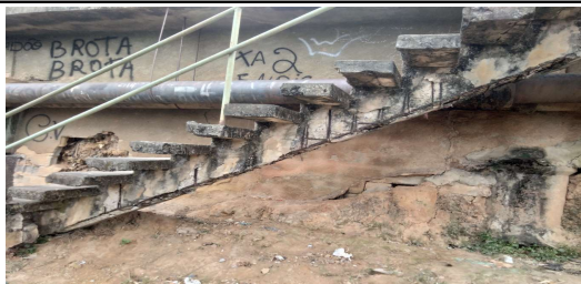
IMAGEM 3: ESTRUTURA DA ESCADA ESPINHA DE PEIXE COM FERRAGEM APARENTE LOCAL: BAIRRO SANTA TEREZINHA
