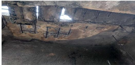
IMAGEM 4: LAJE DO TOPO DA ESCADA ESPINHA DE PEIXE DANIFICADA E COM FERRAGEM APARENTE
