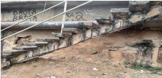
IMAGEM 3: ESTRUTURA DA ESCADA ESPINHA DE PEIXE COM FERRAGEM APARENTE
