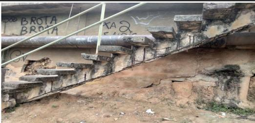
IMAGEM 3: ESTRUTURA DA ESCADA ESPINHA DE PEIXE COM FERRAGEM APARENTE
