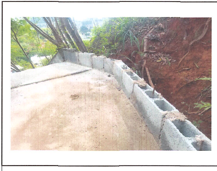
Foto 16: ALVENARIA ARMADA DE BLOCO CHEIO
