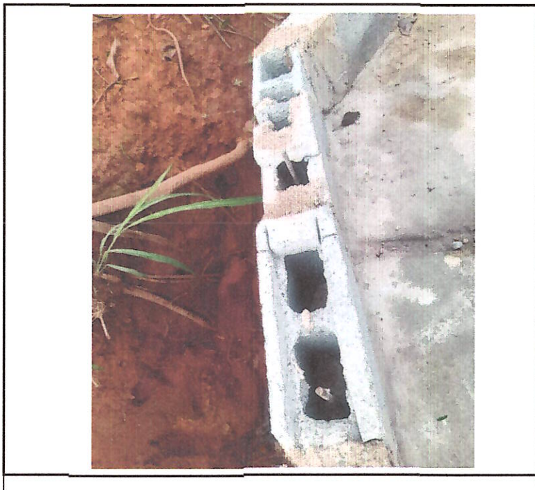
Foto 15: ALVENARIA ARMADA DE BLOCO CHEIO
