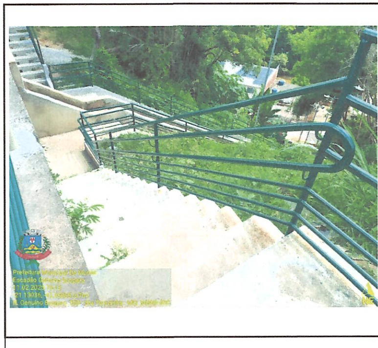
Foto 25: PINTURA GUARDA-CORPO NOVO
