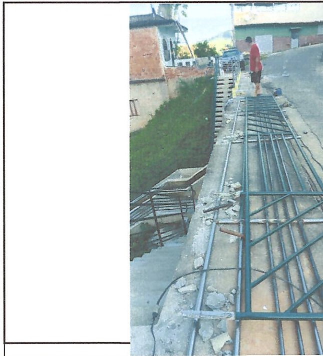
Foto 22: SUBSTITUIÇÃO DO GUARDA-CORPO SUPERIOR
