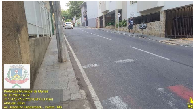
Figura 6: Fotografias antes do recapeamento: Rua Efigênia Freitas da Silva, trecho da Rua Desembargador Canedo e Praça Coronel Pacheco de Medeiros, bairro Centro, Muriaé-MG
