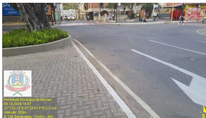
Figura 3: Fotografias antes do recapeamento: Rua Efigênia Freitas da Silva, trecho da Rua Desembargador Canedo e Praça Coronel Pacheco de Medeiros, bairro Centro, Muriaé-MG
