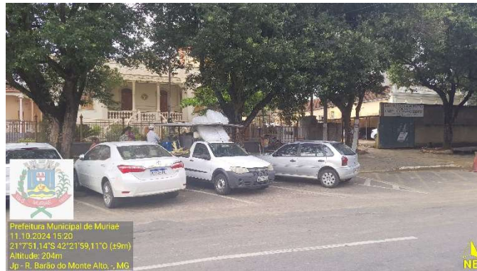
Figura 8: Fotografias antes do recapeamento: Rua Efigênia Freitas da Silva, trecho da Rua Desembargador Canedo e Praça Coronel Pacheco de Medeiros, bairro Centro, Muriaé-MG
