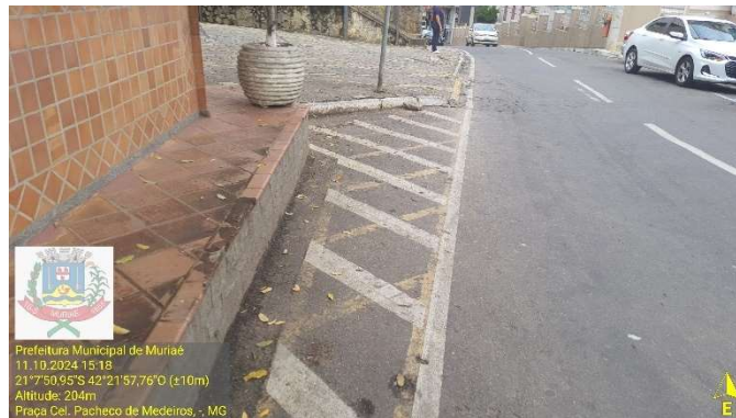
Figura 9: Fotografias antes do recapeamento: Rua Efigênia Freitas da Silva, trecho da Rua Desembargador Canedo e Praça Coronel Pacheco de Medeiros, bairro Centro, Muriaé-MG
