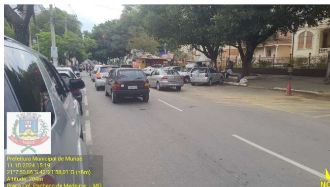
Figura 10: Fotografias antes do recapeamento: Rua Efigênia Freitas da Silva, trecho da Rua Desembargador Canedo e Praça Coronel Pacheco de Medeiros, bairro Centro, Muriaé-MG
