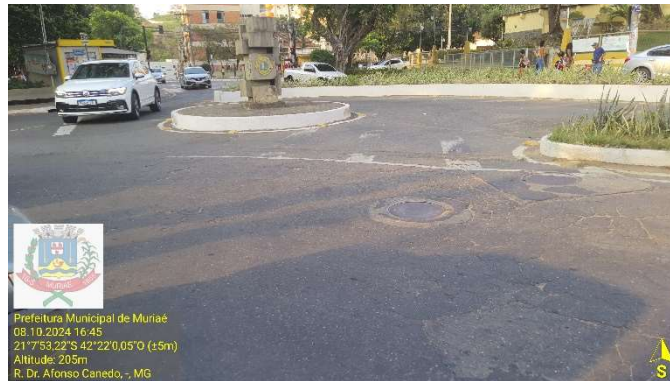
Figura 5: Fotografias antes do recapeamento: Rua Efigênia Freitas da Silva, trecho da Rua Desembargador Canedo e Praça Coronel Pacheco de Medeiros, bairro Centro, Muriaé-MG
