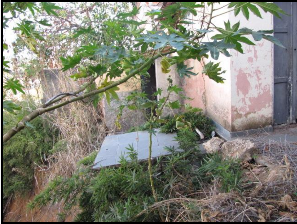
Foto 151 – Detalhe para a posição do restante da estrutura do domicílio em relação a crista do talude.
