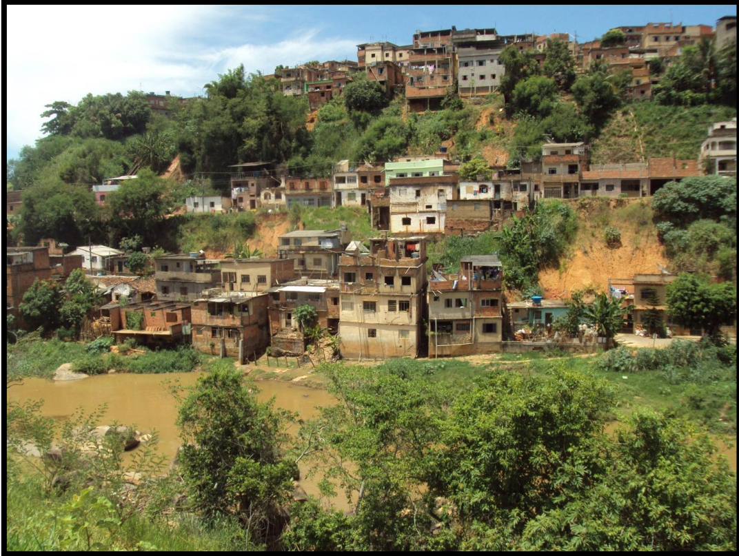
Foto 68 – Detalhe do mesmo setor de risco ressaltando a dinâmica fluvial do rio Muriaé e a suscetibilidade no mesmo setor a deflagração de processos de inundação, solapamentos e escorregamentos de solo.
