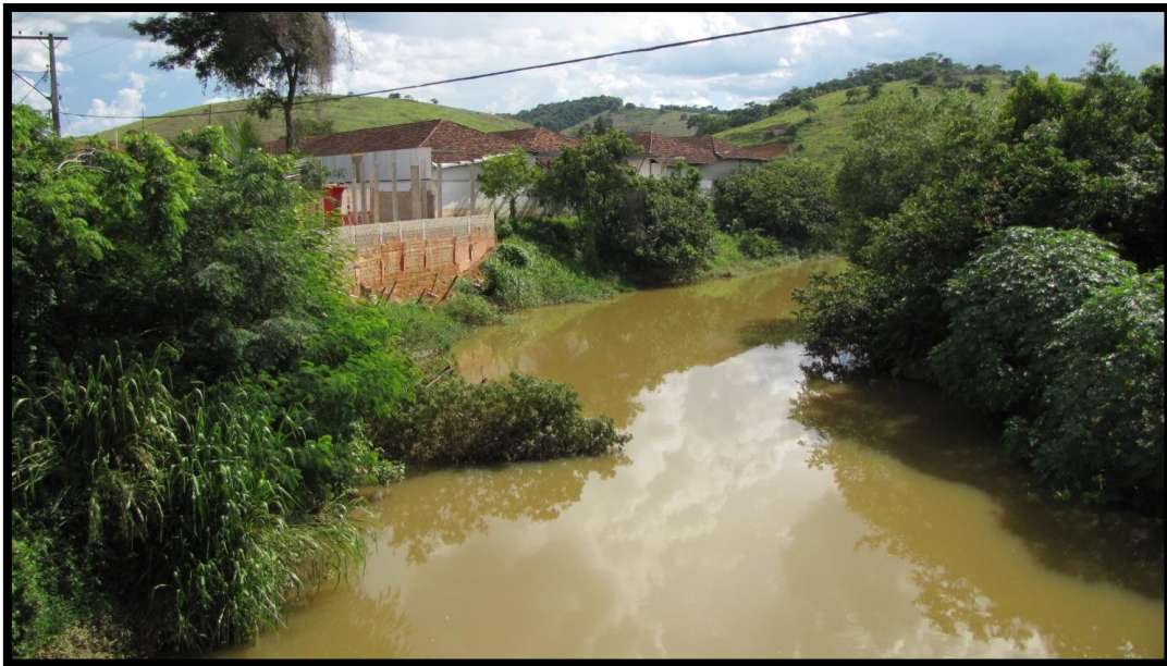
Foto 78 – Detalhe para a construção de uma edificação nas margens do Rio Muriaé em um trecho suscetível a processos de solapamento.
