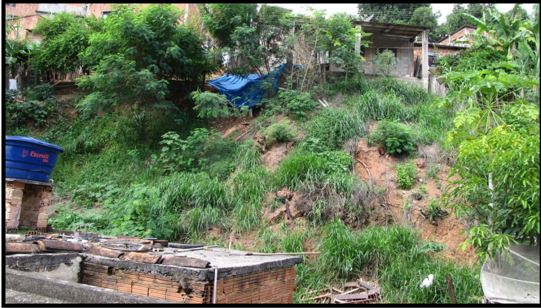
Foto 179 – Detalhe para trecho do setor onde já ocorreram escorregamentos de solo com indícios diretos de que novos movimentos de massa podem ser deflagrados.
