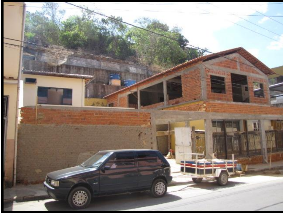
Foto 45 – Vista parcial do setor – trecho com estrutura de contenção.
