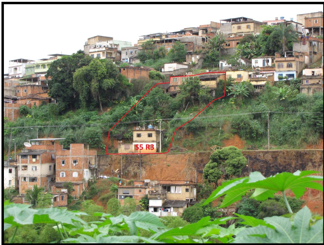
Foto 9 – Vista frontal do setor de risco com destaque para o domicílio da base exposto a novos escorregamentos de solo e a ação das águas superficiais concentradas.
