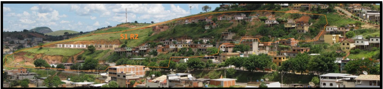
Foto 50 – Vista frontal do setor. Detalhe para a expansão da ocupação.
