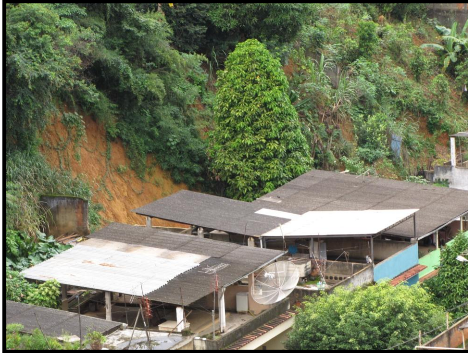
Foto 83 – Detalhe para outra cicatriz de escorregamentos nos fundos de outros dois domicílios do setor.
