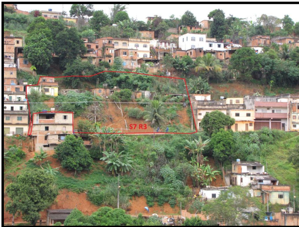
Foto 13 – Vista frontal do setor 7 de risco geológico com detalhe para a ocupação por meio de cortes verticalizados no solo residual para a formação de uma patamar regular.
