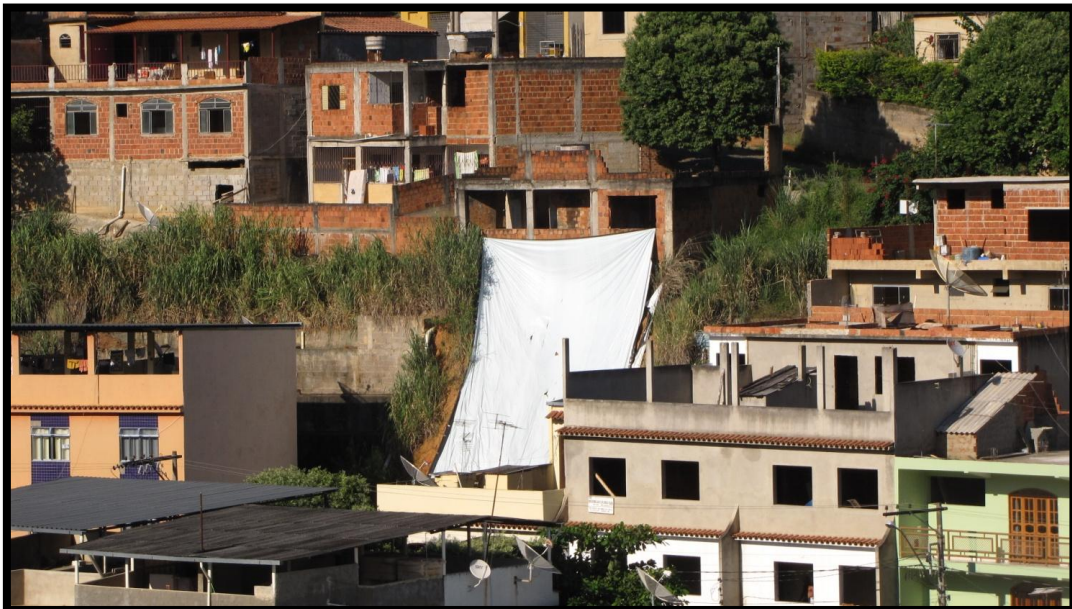
Foto 128 – Vista pontual do setor de risco com domicílio adjacente a crista da encosta com inserção de lona plástica como medida paliativa para controle da ação das águas superficiais.
