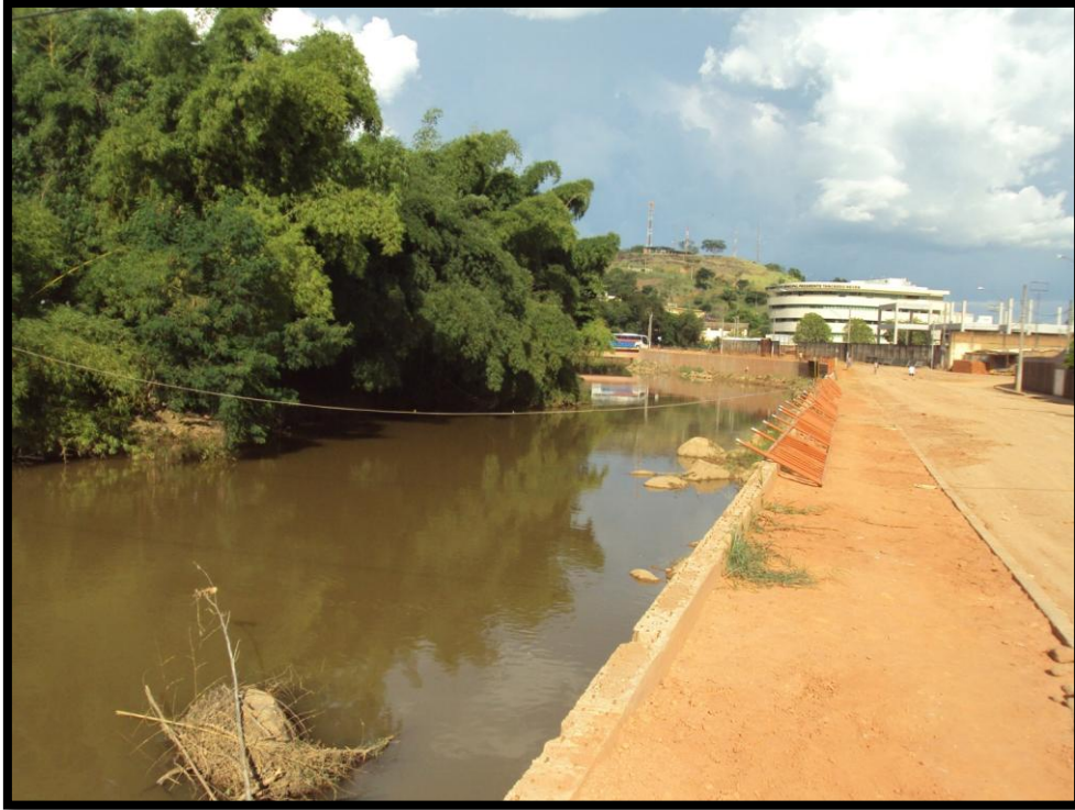
Foto 32 – Trecho do canal próximo a Prefeitura Municipal onde estão sendo executadas intervenções estruturais para a proteção de uma das margens.
