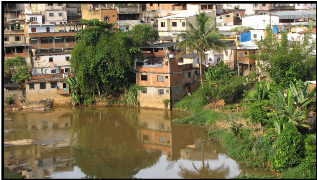
Foto 112 – Detalhe da ocupação dentro do canal onde a intensidade do processo de solapamento é maior.
