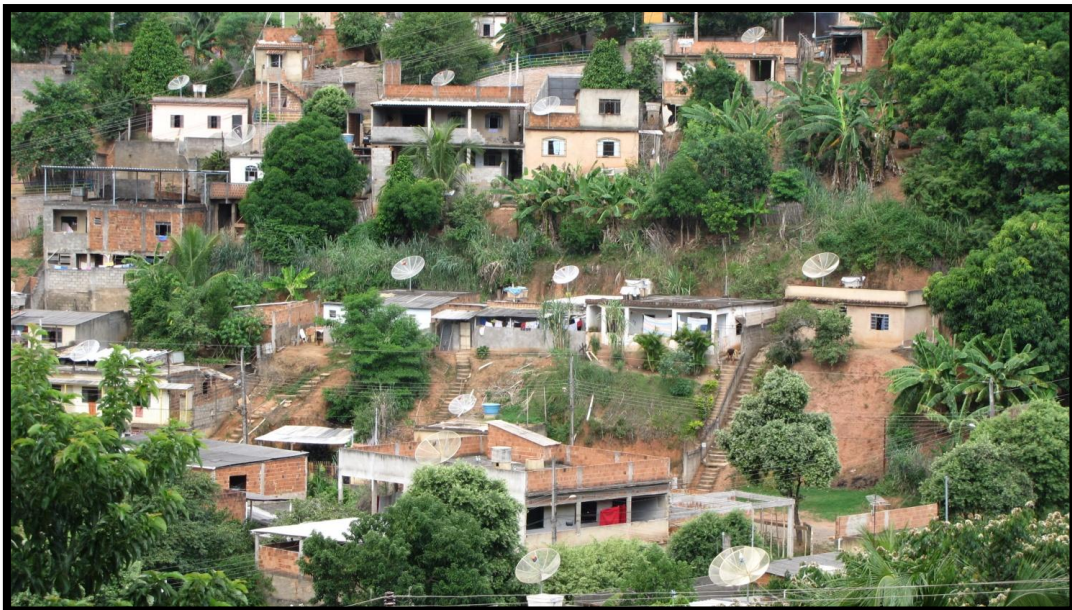
Foto 178 – Ocupação a meia encosta a partir de operações de corte e aterro.
