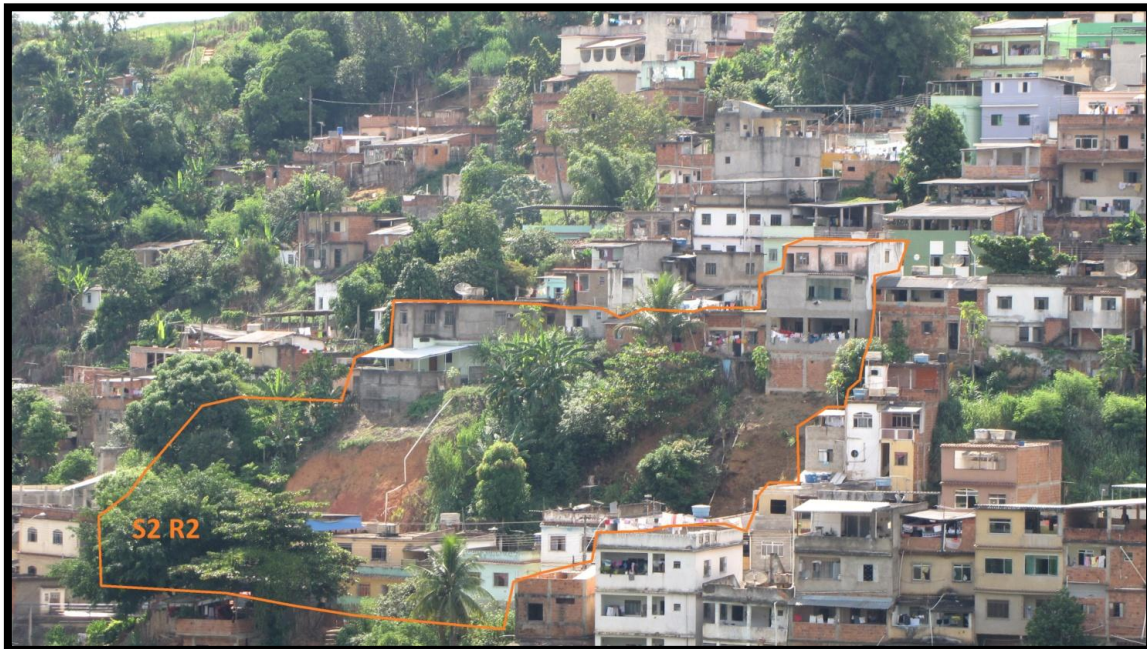
Foto 4 – Vista frontal do setor de risco com destaque para o padrão construtivo dos domicílios. Notar a esquerda do setor alteração da geometria da encosta com talude verticalizado com altura superior a 7,0m.
