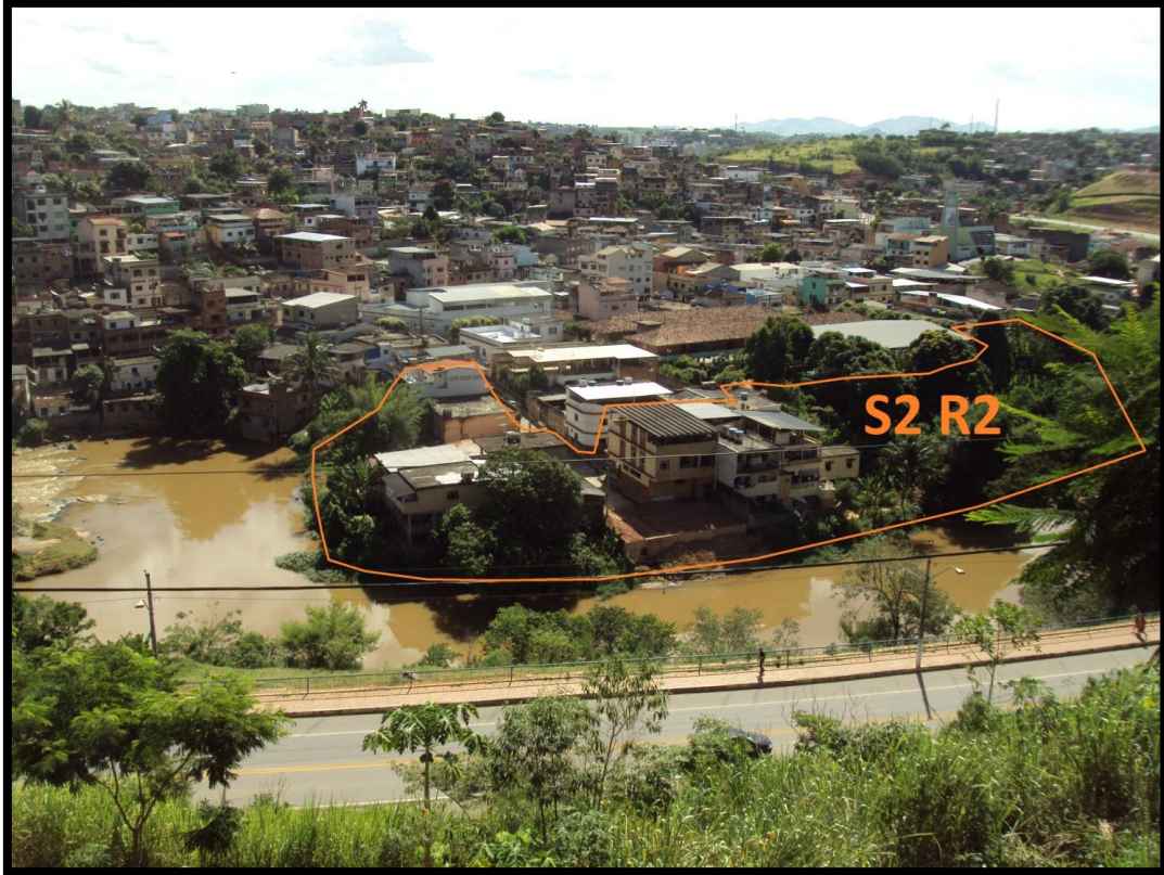
Foto 113 – Vista do limite do setor de risco adjacente ao Rio Muriaé.
