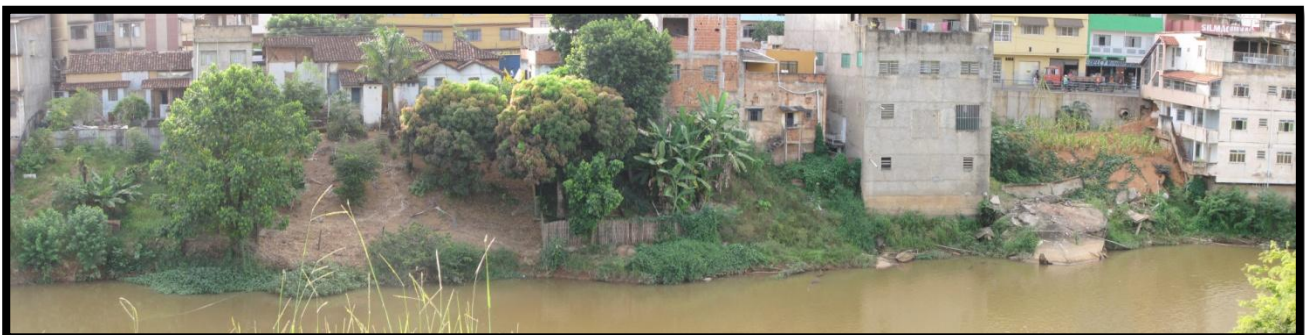
Foto 120 – Vista parcial do setor de risco. Embora o neste trecho o canal seja mais retilíneo diminuindo sua capacidade de solapamento, já ocorreu em um evento de inundação o colapso de um domicílio de 3 pavimentos (a direita da foto) com possibilidade do mesmo processo afetar os domicílios do entorno e do setor.
