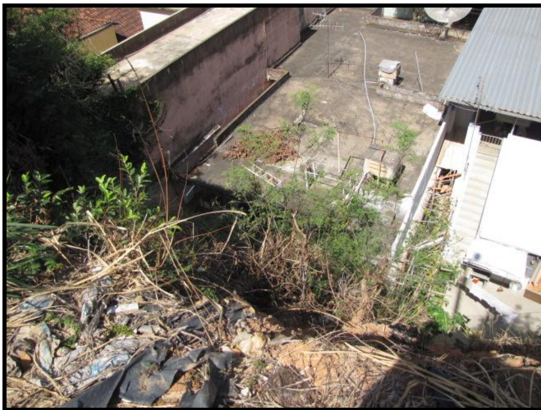
Foto 43 – Cicatriz de escorregamento anterior com possibilidade de recorrência do processo.
