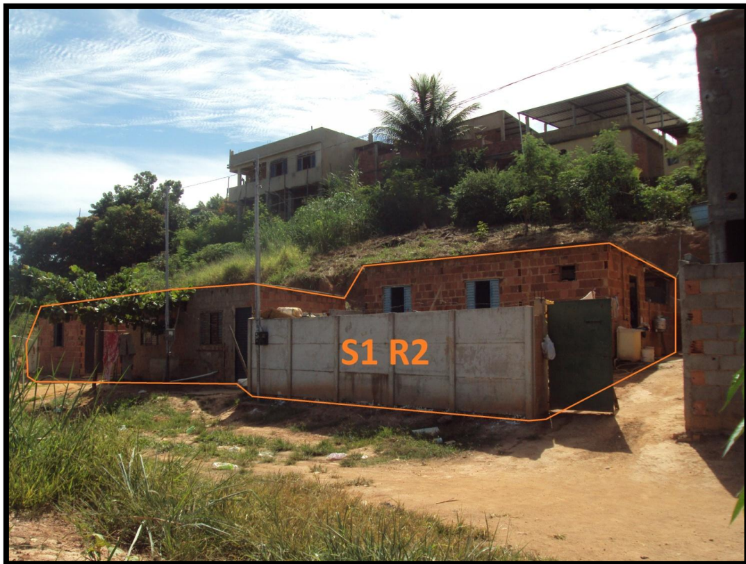
Foto 99 – Vista frontal do setor. Início do processo de ocupação do local.
