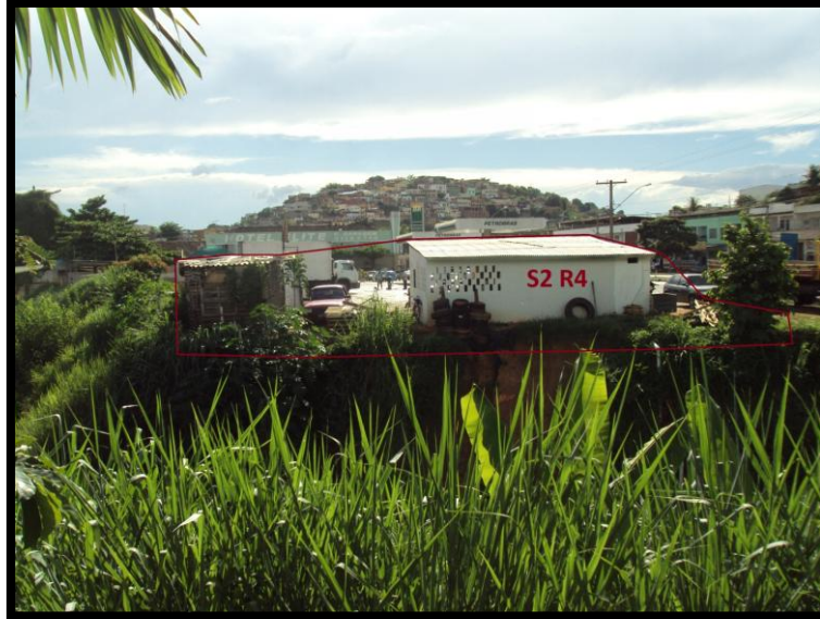
Foto 48 – Vista lateral do setor de risco onde os processos de solapamento podem acarretar no colapso total das estruturas.
