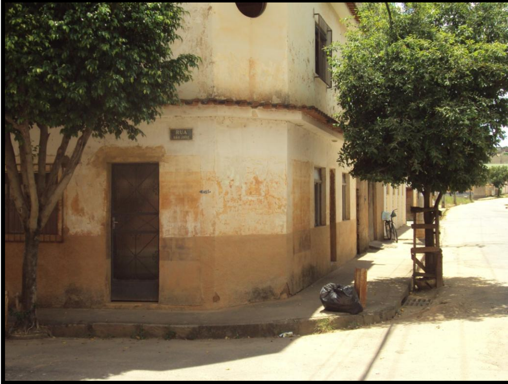
Foto 108 – Marcas nas paredes de um dos domicílios relacionadas ao último episódio de inundação.
