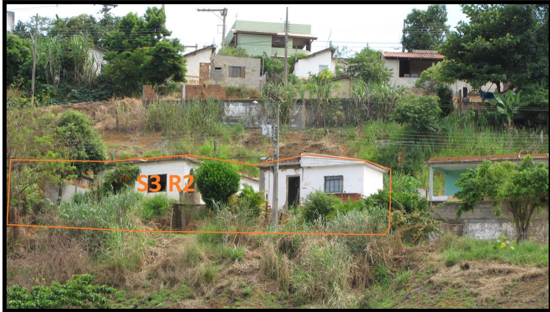
Foto 91 – Vista frontal do setor 3 de risco geológico.
