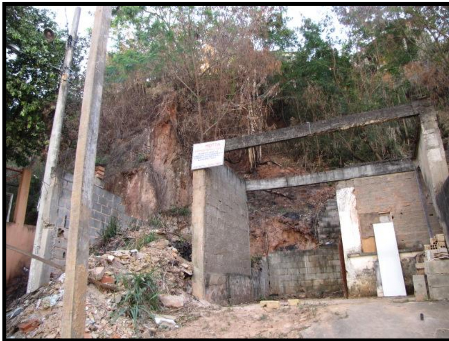
Foto 148 – Detalhe do trecho da encosta onde ocorreram escorregamentos de solo mobilizando volumes significativos de material.
