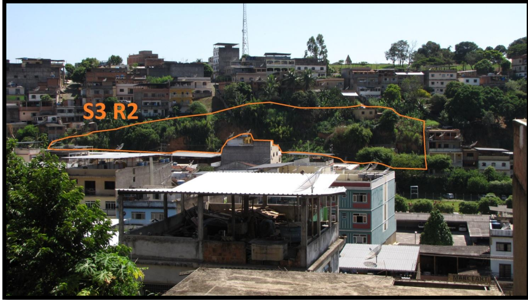
Foto 141 – Delimitação do setor e de risco geológico. Detalhe para o desnível entre a base e o topo da encosta.
