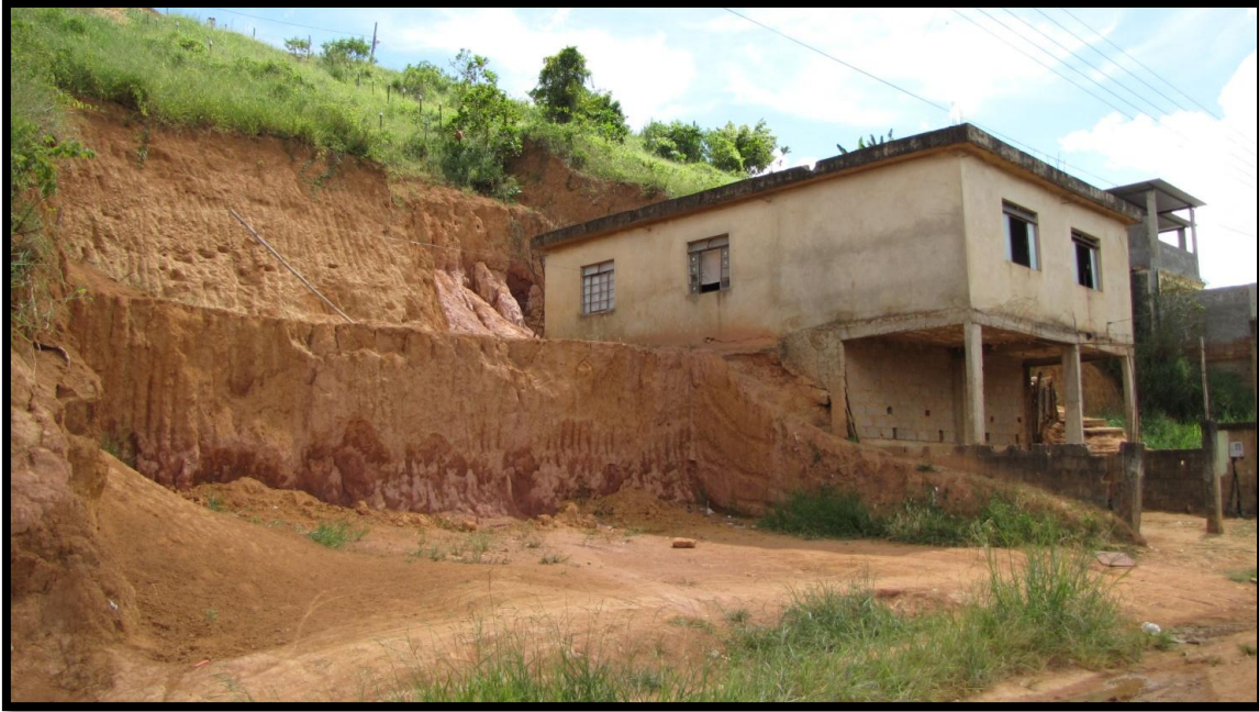
Foto 52 – Detalhe para a tipologia das novas edificações que estão sendo construídas. Cortes verticalizados não contidos e exposição do terreno.
