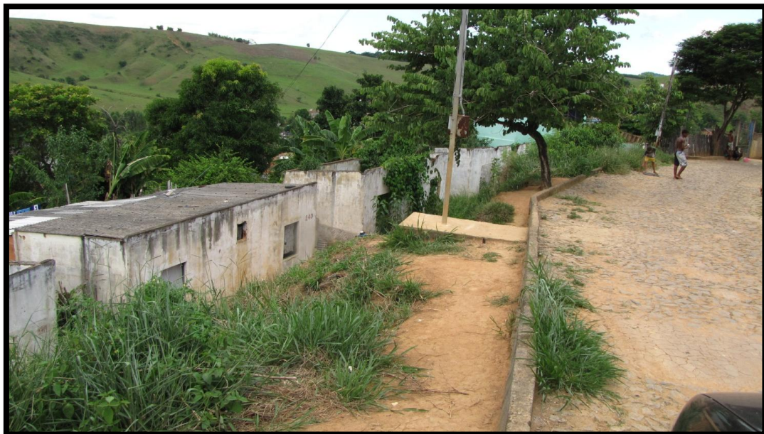
Foto 181 – Vista parcial do setor. Domicílio abandonados e de baixo padrão construtivo.
