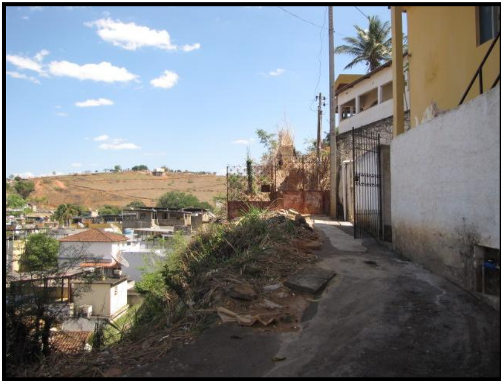
Foto 41 – Detalhe para a rua sem saída a montante do setor. O escoamento das águas superficiais é parcialmente direcionado para a encosta. Presença de aterro e entulho na crista. O avanço dos processos de escorregamento acarretará no impedimento do acesso aos domicílios da crista.
