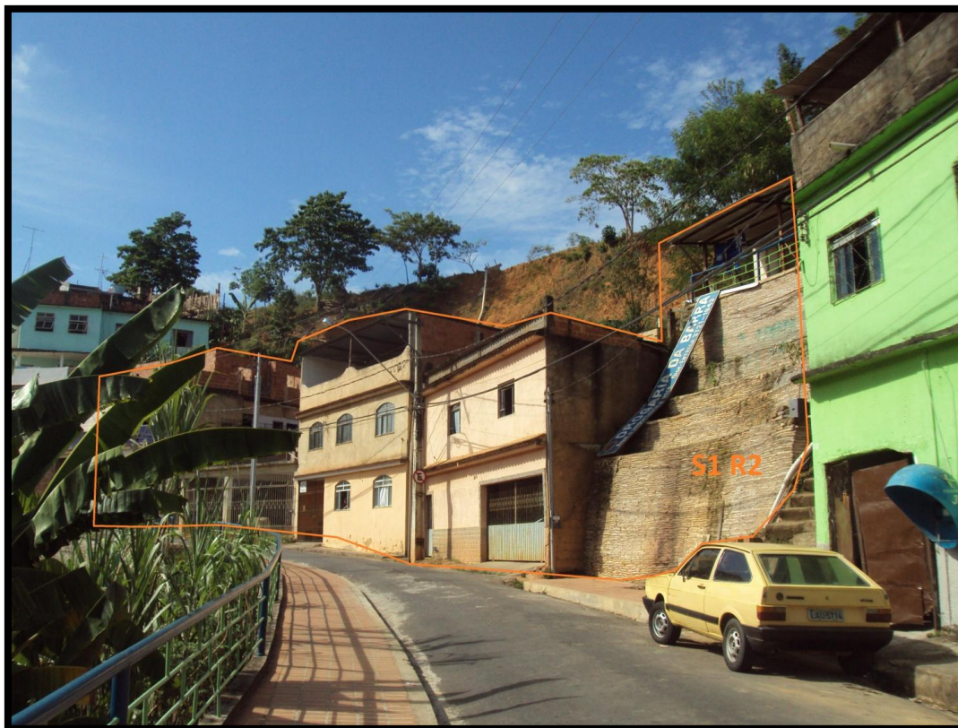
Foto 200 – Vista frontal do setor de risco. Bom padrão construtivo dos domicílios e talude inclinado exposto nos fundos.
