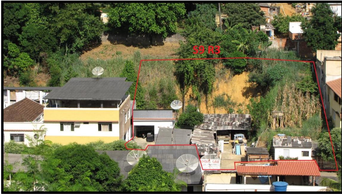
Foto 40 – Vista frontal do setor de risco com destaque para a cicatriz de escorregamento pretérita e a exposição do terreno a processos erosivos.
