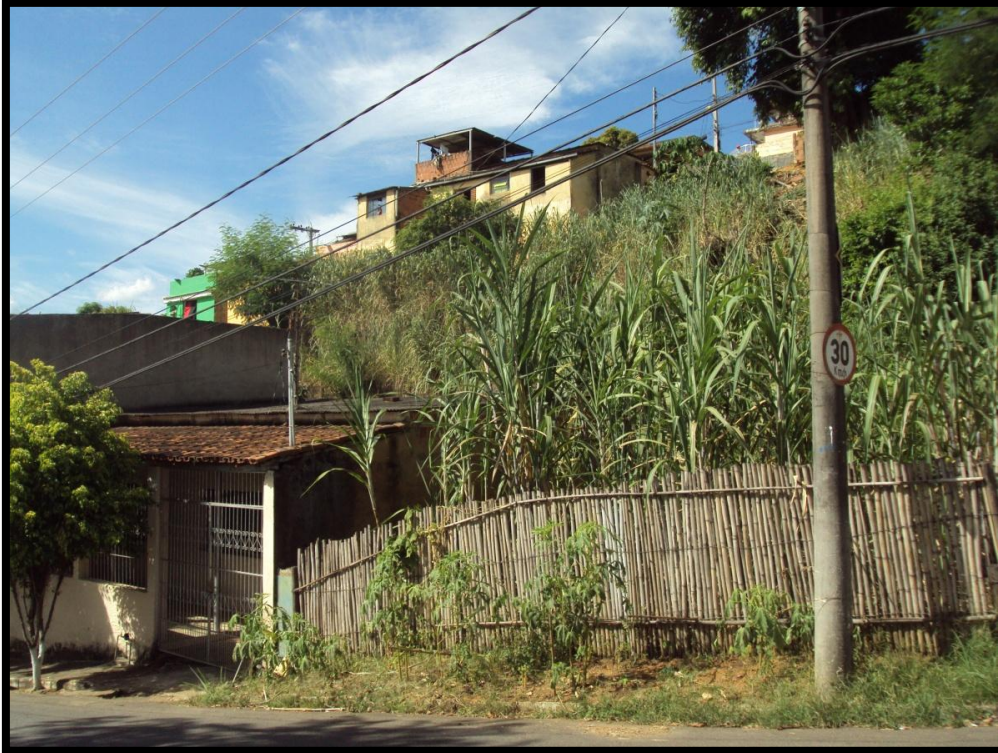
Foto 207 – Vista parcial do setor de risco. Domicílios na base e na crista da encosta.
