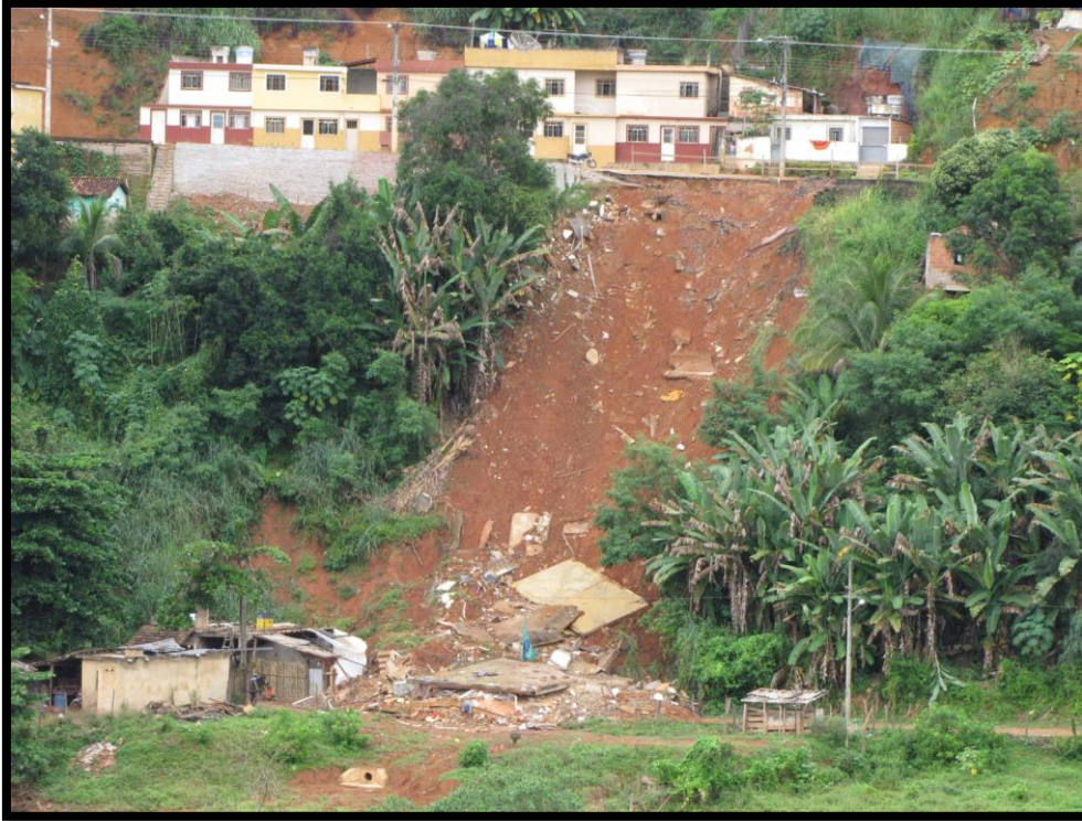
Foto 194 – Detalhe para área onde ocorreu um escorregamento com a destruição de um domicílio de três pavimentos. O domicílio ao lado continua ocupado.
