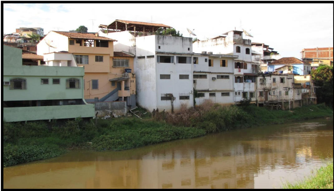
Foto 121 – Vista parcial do setor de risco com detalhe para o padrão construtivo dos domicílios que chegam a ter até 4 pavimentos.
