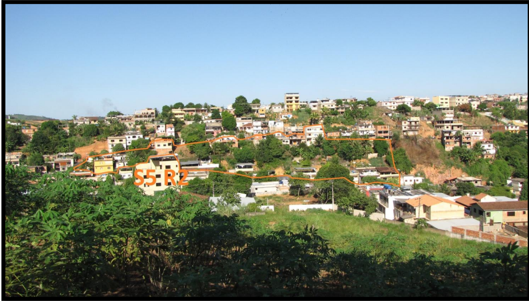
Foto 132 – Delimitação do setor 5 de risco geológico.
