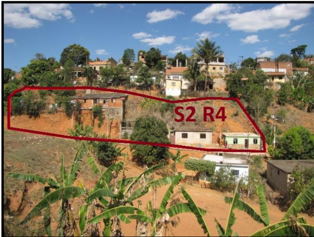
Foto 100 – Vista frontal do setor de risco. Domicílios de baixo padrão construtivo, indícios de movimentação do terreno e histórico de escorregamentos.
