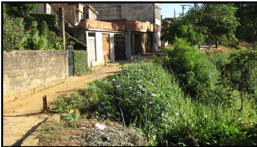
Foto 84 – Foto da Rua 1 de Maio a montante da cabeceira do talvegue e do setor 1 de risco. Trecho onde já ocorreram escorregamentos de solo sendo que a progressão deste impossibilitou o uso da mesma para o tráfego de veículos. Ausência de infra-estrutura e direcionamento de todo o escoamento das águas superficiais diretamente para a encosta.
