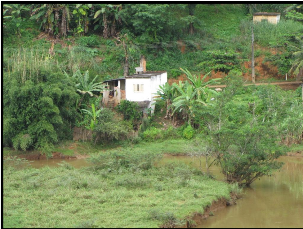
Foto 195 – detalhe para domicílio adjacente ao Rio Preto em área suscetível a solapamentos e inundações.
