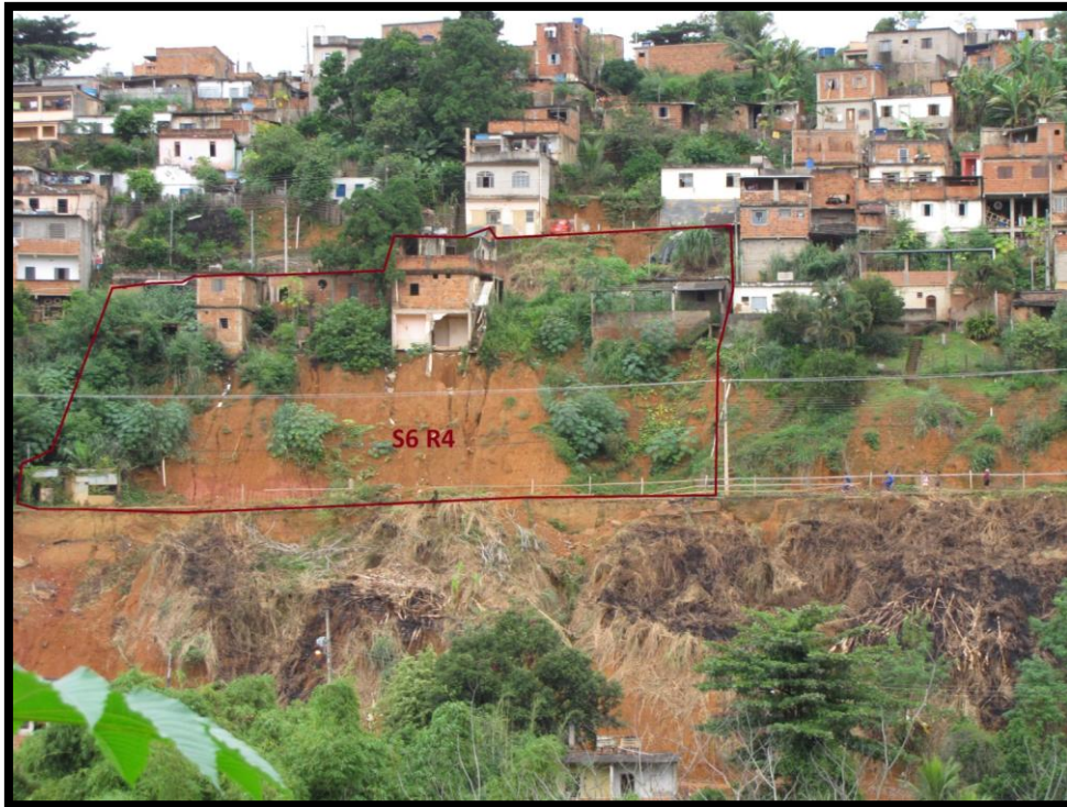
Foto 10 – Vista frontal do setor. O domicílio de 2 pavimentos estava em processo de ser demolido após colapso parcial.
