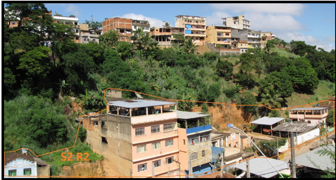
Foto 174 – Delimitação do setor de risco geológico. Detalhe para o padrão dos domicílios e a posição dos mesmos em relação a encosta.
