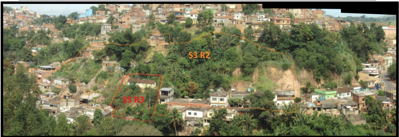
Foto 158 – Delimitação do setor de risco geológico.
