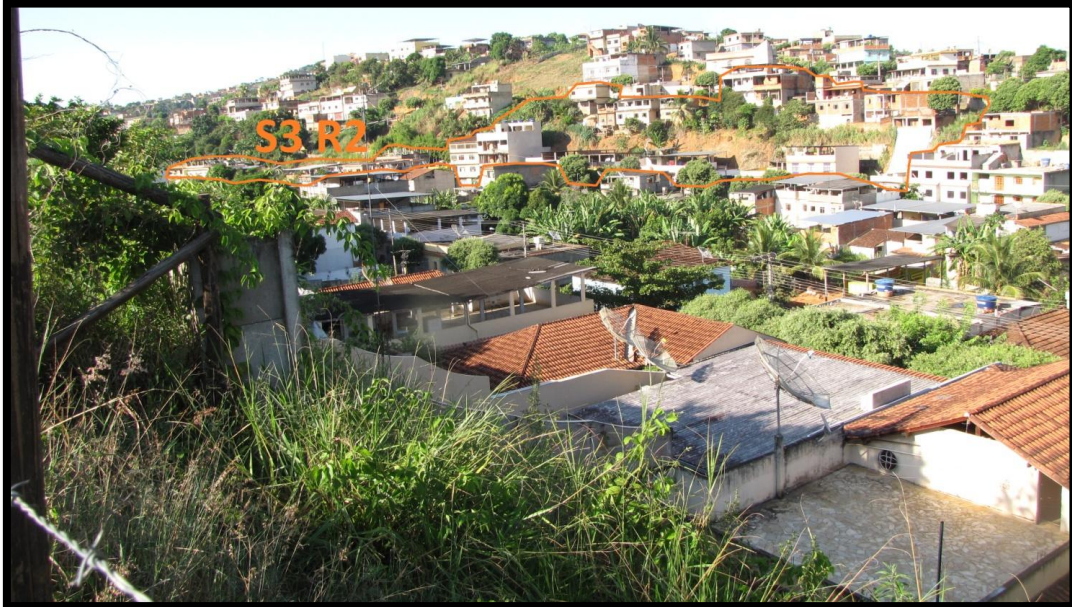
Foto 127 – Delimitação do setor de risco geológico com detalhe para o desnível elevado entre a base e a crista da encosta.
