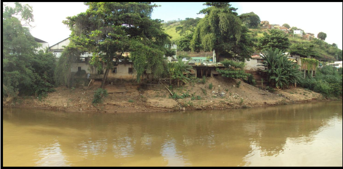
Foto 47 – Vista parcial do setor de risco com detalhe para o fato do nível de água ultrapassar as estruturas próximas ao canal atingindo o pátio das empresas.
