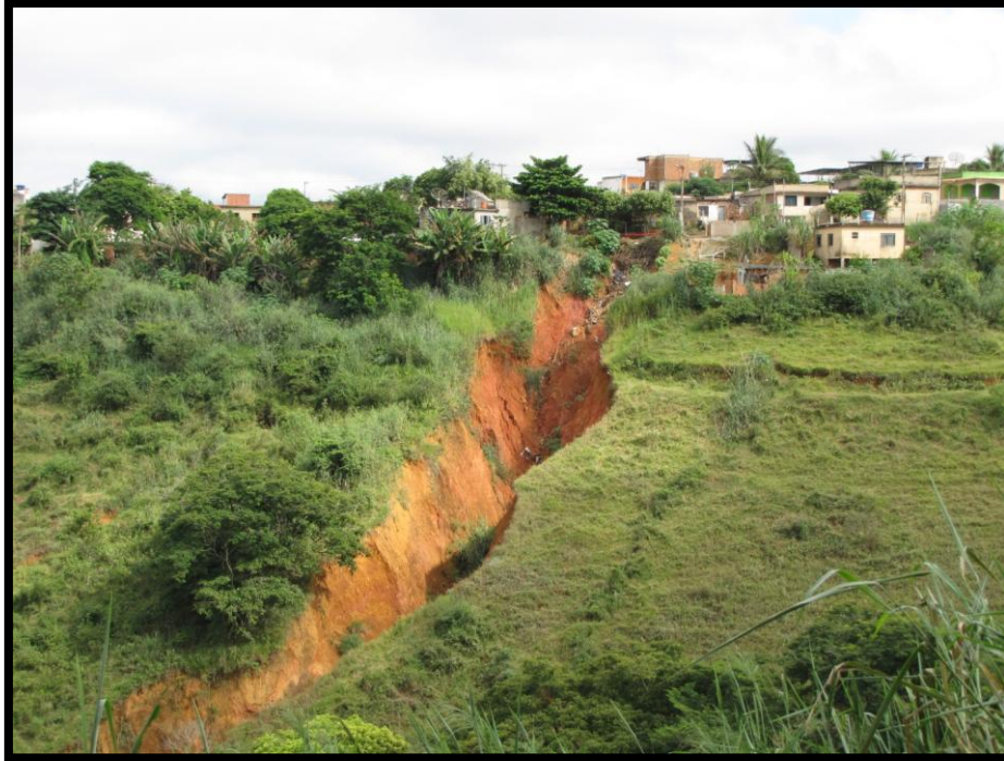
Foto 133 – Vista frontal do processo erosivo linear (ravina). Imagem adquirida em uma das campanhas de mapeamento no município.
