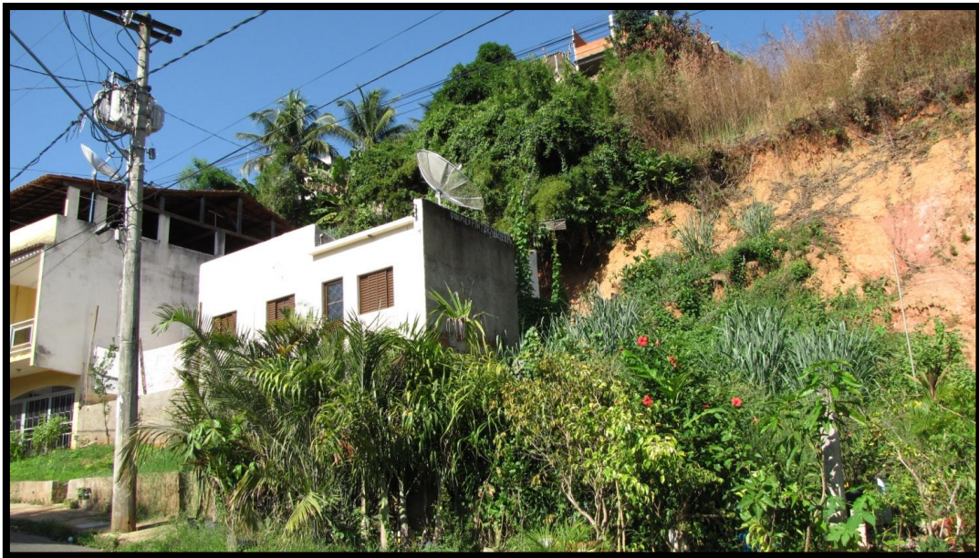
Foto 131 – Vista complementar a foto anterior destacando o domicílio de um pavimento e a proximidade do mesmo em relação a encosta instável.
