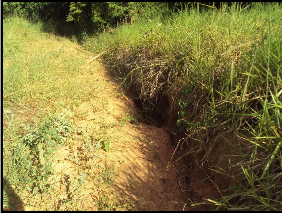
Foto 203 – Lançamento do escoamento superficial da Rua Jardim América diretamente na encosta. Canaleta esculpida diretamente no terreno.
