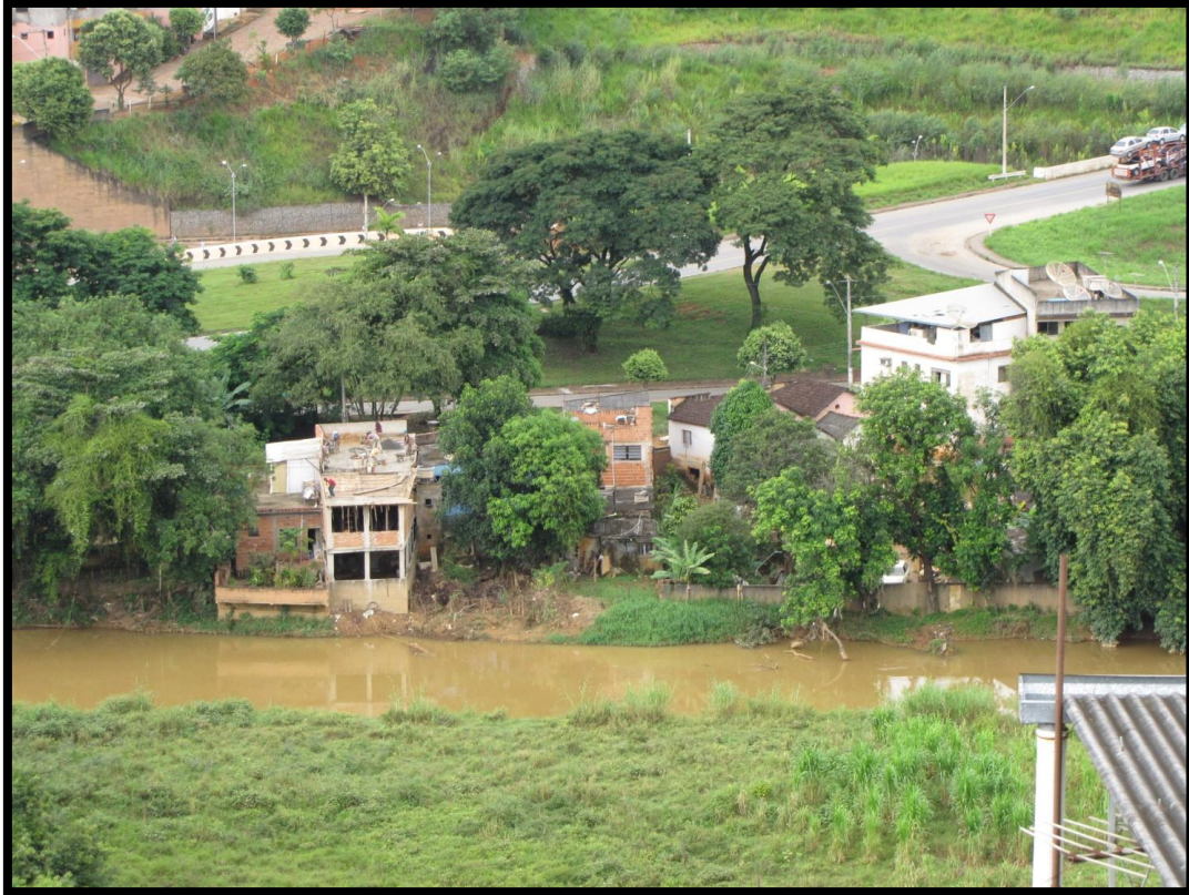
Foto 65 – Domicílios construídos adjacente ao Rio Muriaé. Área próximo a alça viária referente a entrada da cidade onde os processos de inundação são recorrentes com elevação de 2,0m do nível do Rio Muriaé.
