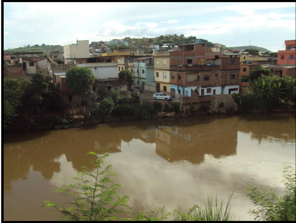
Foto 37 – Erosão da margem com colapso parcial do trecho final da via veicular. Os domicílios inseridos no setor estão sujeitos aos mesmos processos.
