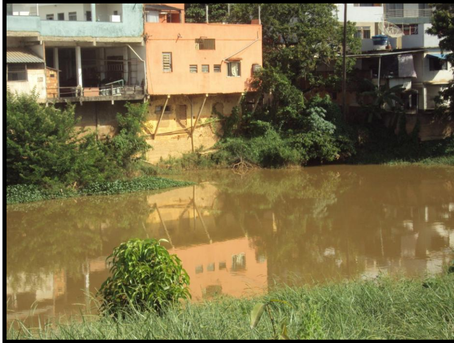
Foto 30 – Detalhe para domicílios que foram construídos no mesmo nível do canal estando estes sujeitos além dos processos de inundação, a serem atingidos por quaisquer materiais transportados e arrastados quando do aumento do volume do canal no período de chuvas. Considerando a dinâmica fluvial trata-se de um trecho suscetível aos processos de solapamento da margem ocupada.
