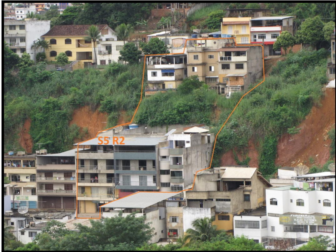
Foto 29 – Delimitação e localização do setor 5 de risco geológico do PMRR.
