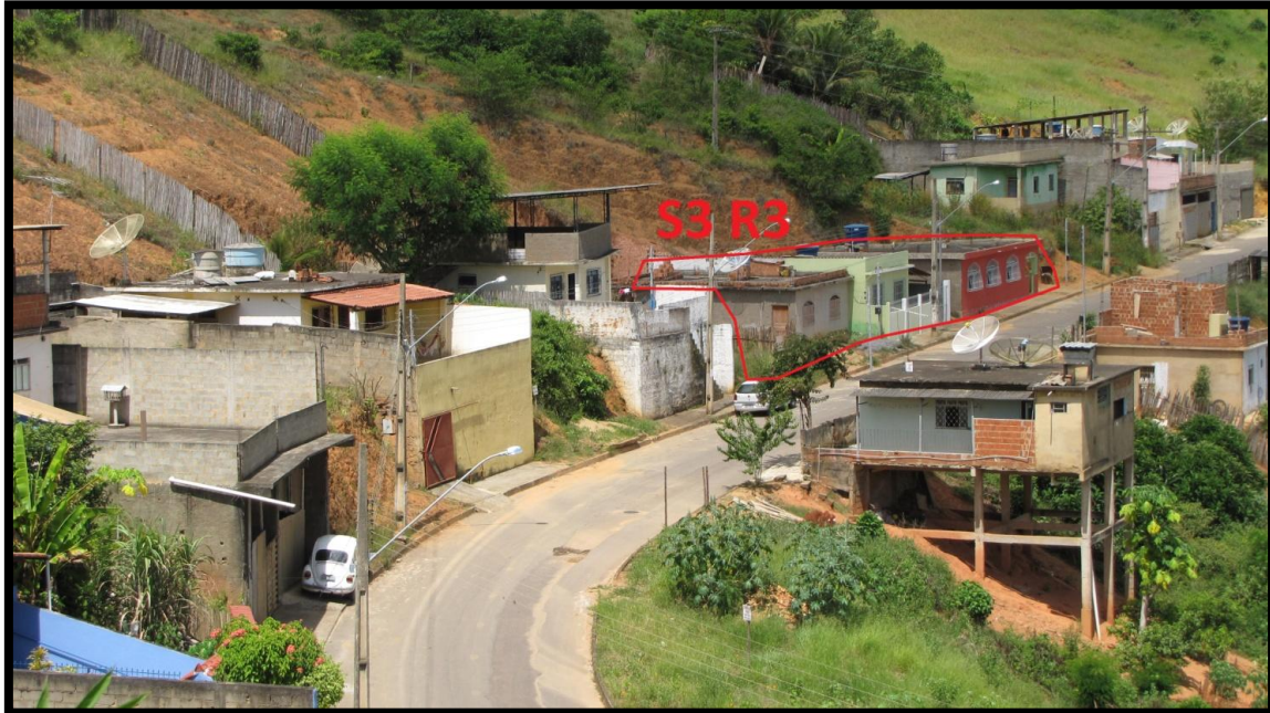
Foto 56 – Vista lateral do setor de risco. Domicílios de um pavimento e área urbanizada.
