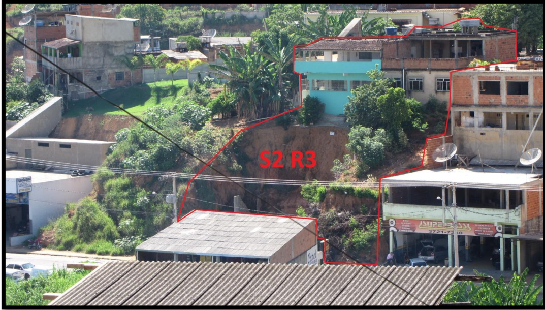
Foto 61 – Vista frontal do setor de risco com detalhe para a proximidade do domicílio de cor verde em relação a cicatriz de escorregamento.
