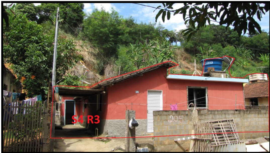
Foto 92 – Vista frontal do setor de risco geológico.
