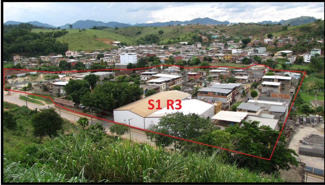
Foto 77 – Delimitação do setor 1 de risco geológico. Relevo plano. A partir do histórico de inundações pode-se afirmar que todo o setor é suscetível a recorrência destes processos.
