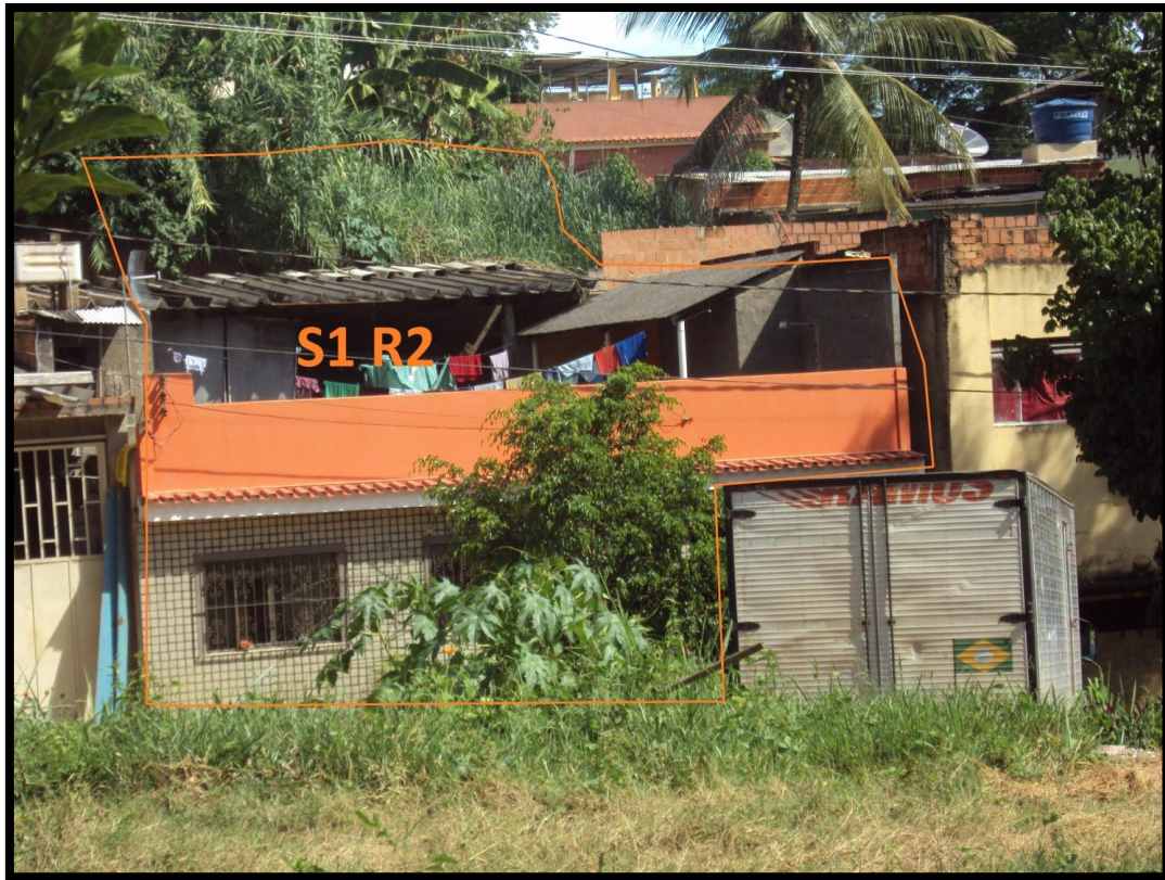
Foto 205 - Vista frontal do setor de risco.
