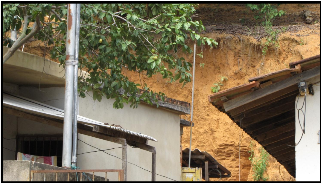
Foto 88 – Detalhe para o talude verticalizado nos fundos dos domicílios alterados no processo de ocupação do local.
