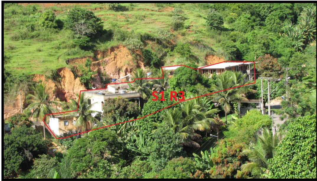
Foto 168 – Vista frontal do setor de risco com detalhe para os processos erosivos lineares que podem evoluir para escorregamentos de solo.
