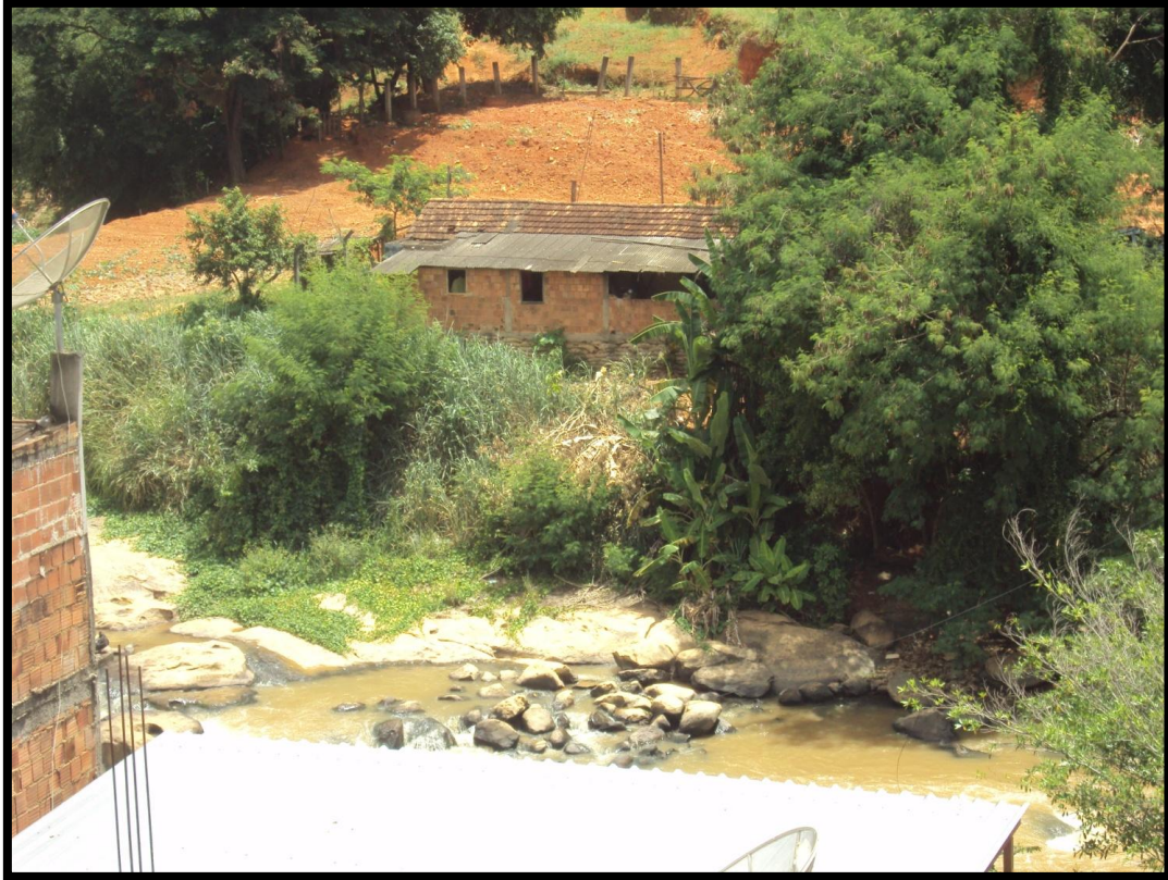
Foto 106 – Vista parcial do trecho 2 do setor de risco sendo esta área suscetível a processos de solapamento intensos.
