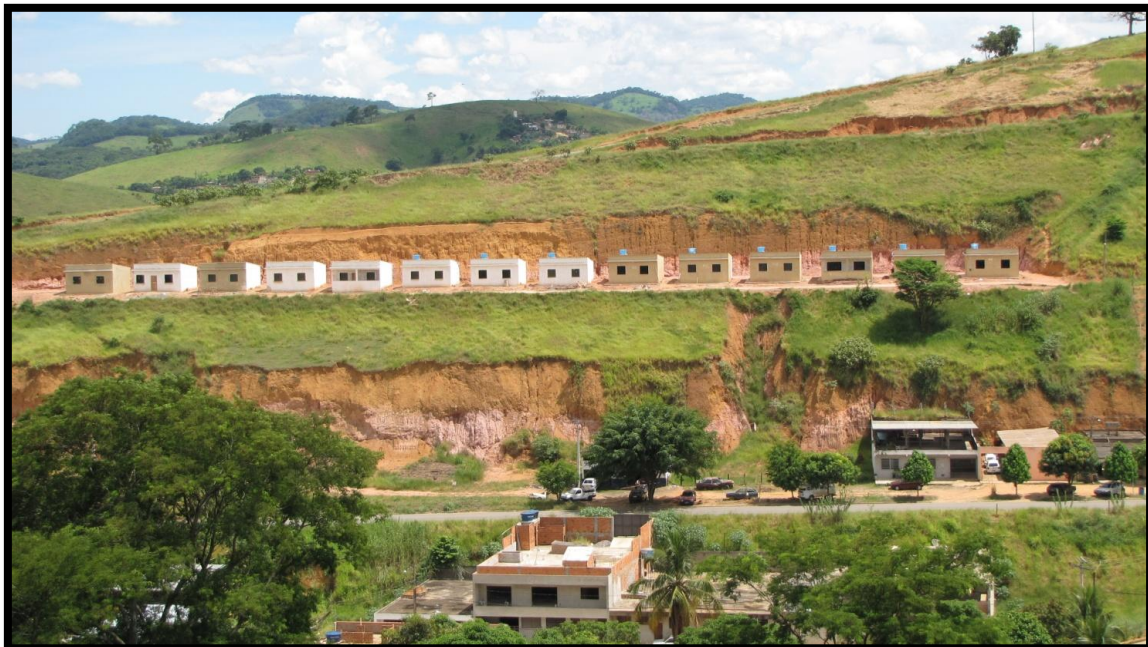
Foto 51 – Vista parcial do setor. Construção de habitações populares. Detalhe para feição erosiva.
