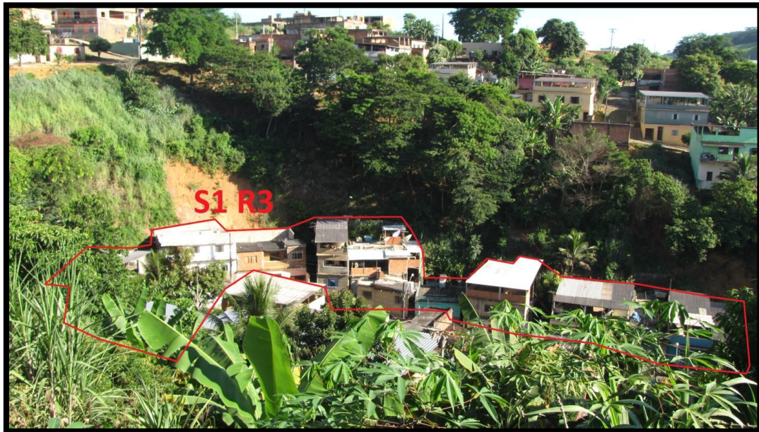
Foto 80 – Cabeceira do talvegue ocupada. Detalhe para uma extensa cicatriz de escorregamento e para a inclinação da encosta.
