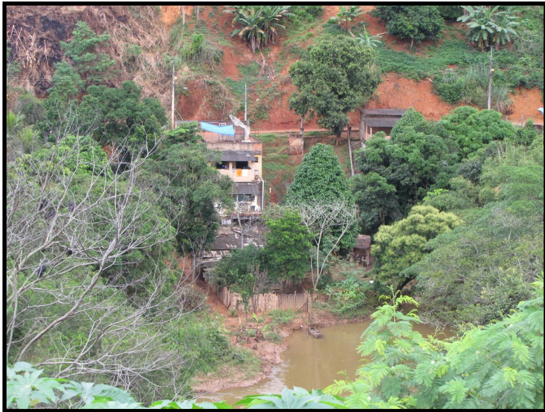
Foto 188 – Vista parcial do setor de risco com detalhe para domicílios que ocupam as margens do Rio Preto em um trecho suscetível a solapamento.
