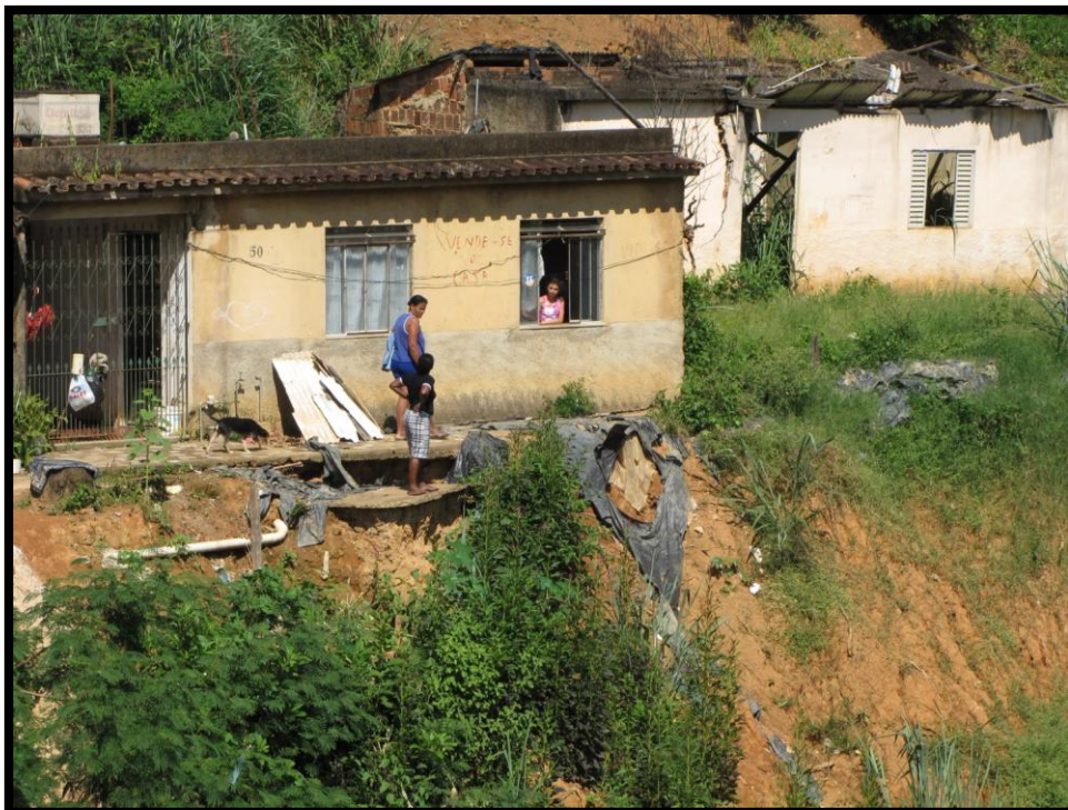
Foto 173 – Detalhe para a condição de um domicílio após a deflagração de escorregamentos, domicílio ainda ocupado.
