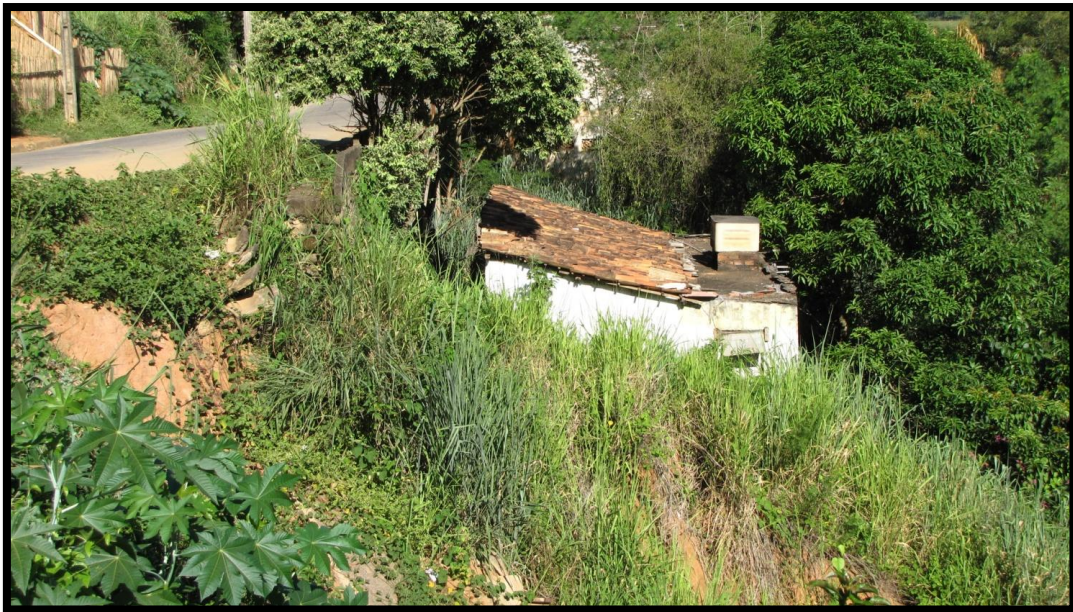
Foto 197 – Domicílio imediatamente a jusante do trecho retratado na foto anterior.
