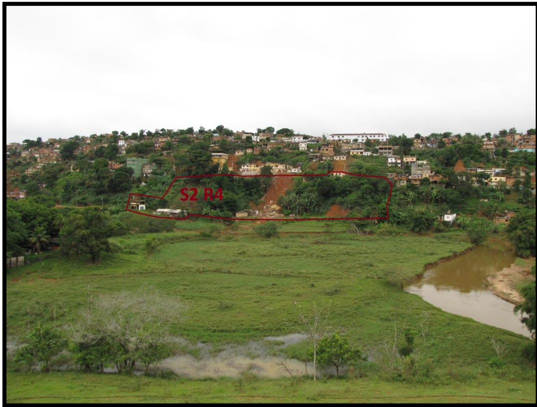
Foto 193 – Delimitação do setor de risco geológico.
