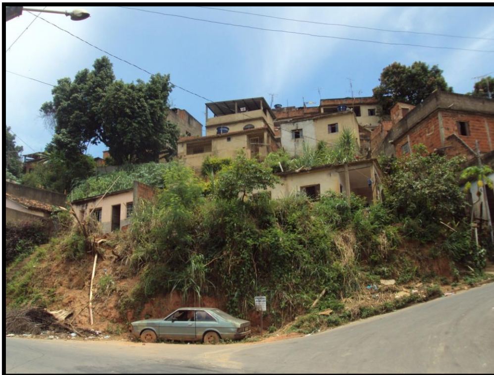
Foto 154 – Vista parcial do setor de risco. Domicílios de baixo padrão construtivo e talude de corte nos fundos dos mesmos com afastamento inferior a 2,0m.
