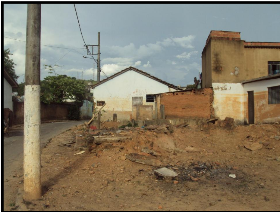
Foto 31 – Detalhe para as marcas nas paredes dos domicílios indicando a altura (2,0m) da área atingida pelo último episódio de inundação.
