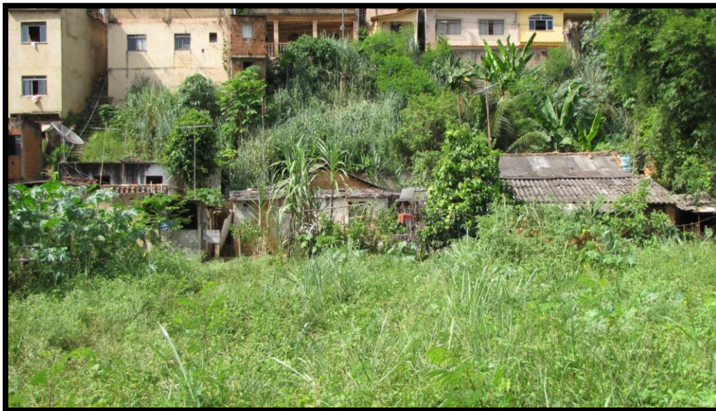
Foto 72 – Vista de parte do setor de risco. Domicílios de baixo padrão construtivo construídos na base de taludes de corte em área suscetível a ocorrerem pequenos escorregamentos de solo / bananeiras e aterros.
