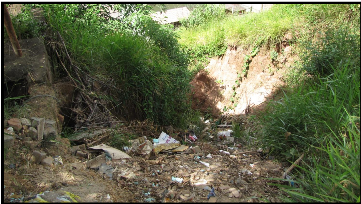
Foto 55 – Feição erosiva de grande porte adjacente ao domicílio.
