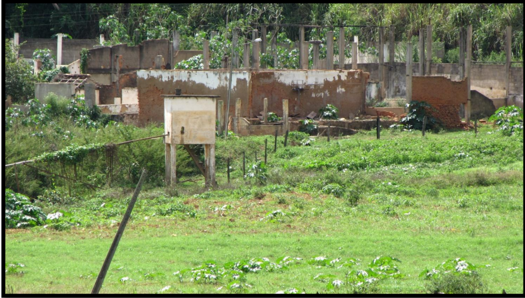
Foto 64 – Estrutura abandonada descrita na foto anterior com destaque para a marca deixada nas paredes do último processo de inundação ( h = 5,0\text{m} )
