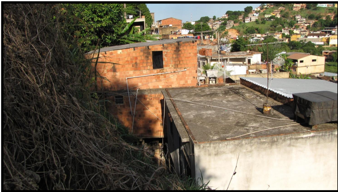
Foto 3 – Detalhe para a inclinação elevada da encosta e afastamento pequeno dos domicílios em relação a mesma, na base do setor de risco.
