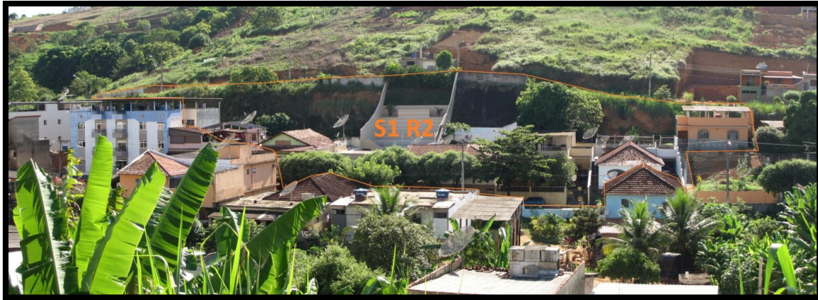
Foto 123 – Vista frontal dos setor de risco geológico. Área consolidada e domicílio com bom padrão construtivo.
