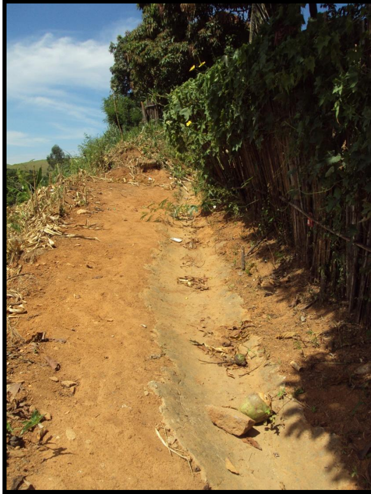
Foto 104 – Tentativa de inserção de uma canaleta na crista da encosta para o desvio do escoamento das águas superficiais.
