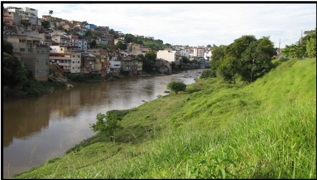
Foto 122 – Vista complementar do setor no limite entre os bairros Porto e Centro com destaque para ocupação em toda a margem do Rio Muriaé.
