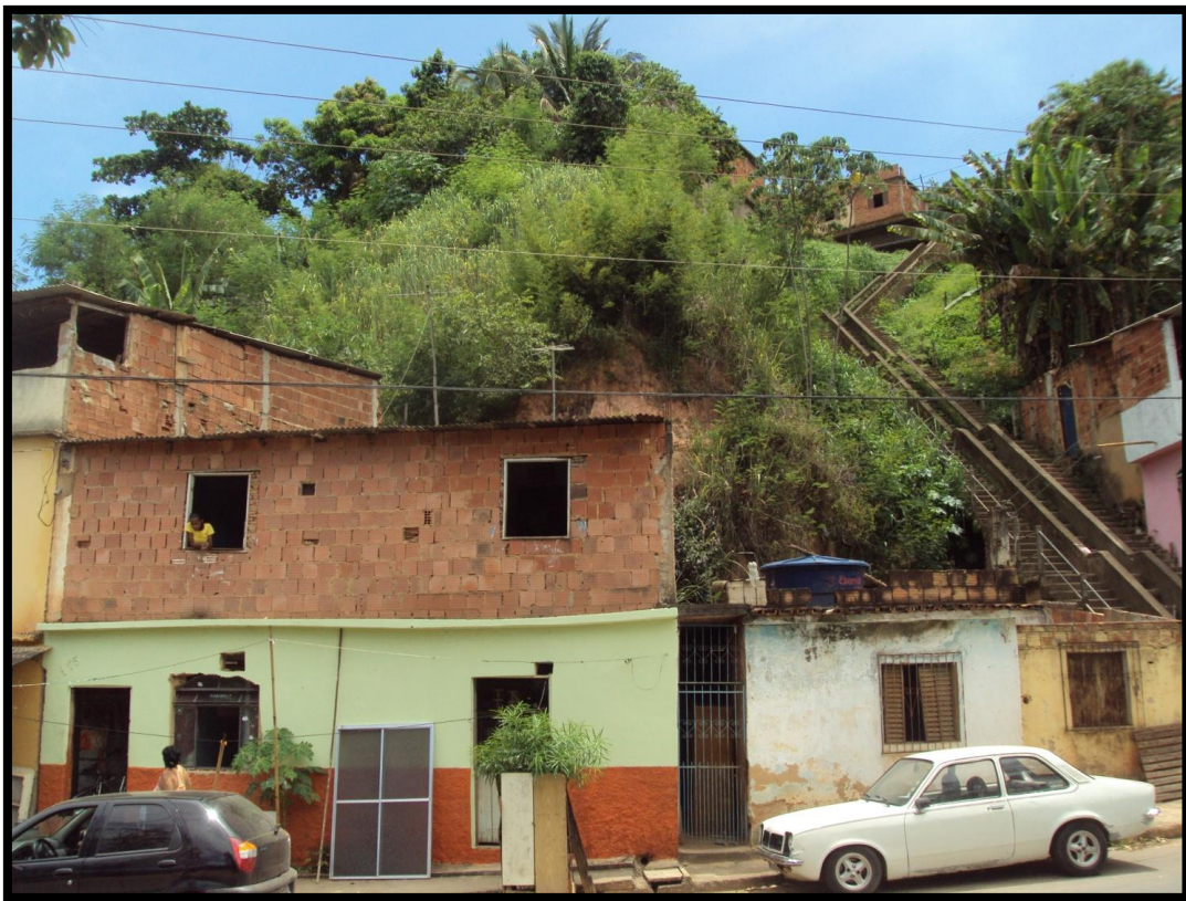
Foto 157 – Vista parcial do setor de risco. Destaque para ocupação na base dos taludes de corte.
