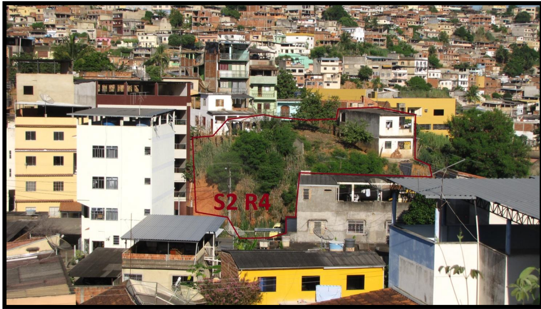
Foto 126 – Vista frontal do setor de risco. Detalhe para o domicílio da crista do setor onde já ocorreram escorregamentos anteriores.
