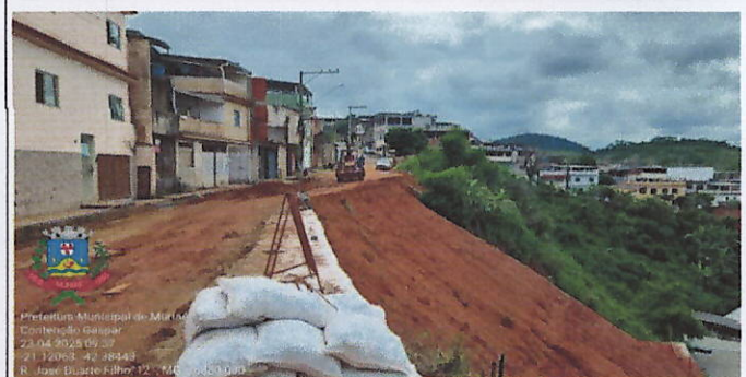
Figuras 7 e 8 - Aterro e compactação
