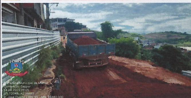
Figuras 5 e 6 - Aterro e compactação
