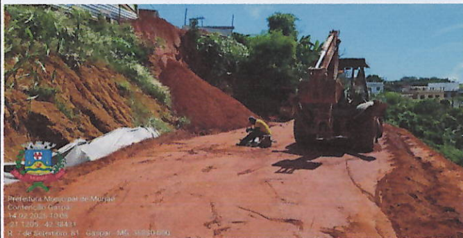
Figuras 1 e 2 - Aterro e compactação do solo na parte superior do muro de contenção; ensaios de controle de terraplenagem; filtro de mat. granular
