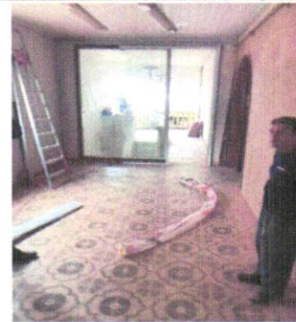
IMAGEM 8: SALA CENTRAL SEM PINTURA LOCAL: E.M. JOSÉ MIGUEL MUAHAD
