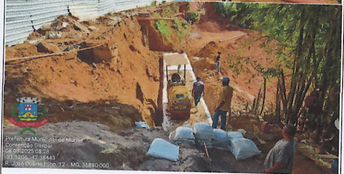
Figuras 3 e 4 - Nivelamento e compactação da base, muro de solo-cimento assado e compactado
