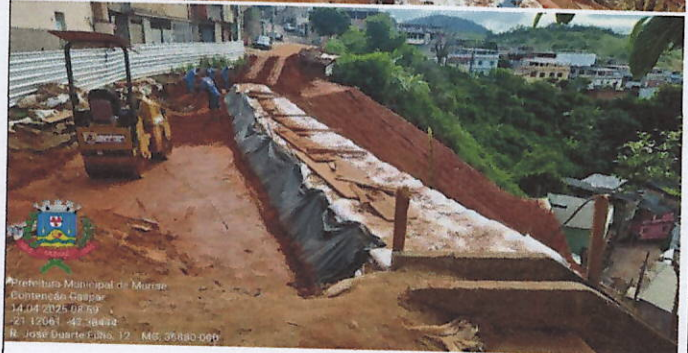
Figuras 7 e 8 - Escavação de restauro compactado, execução de drenagem
