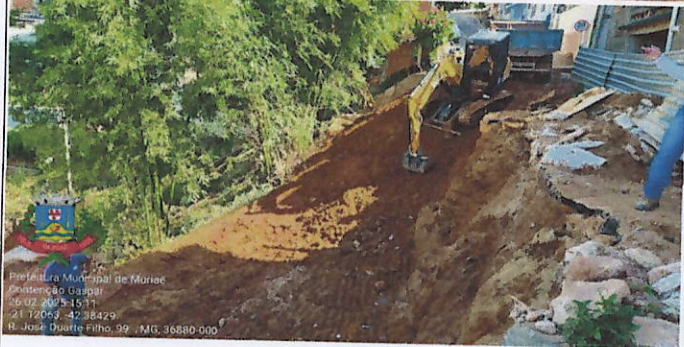
Figuras 1 e 2 - Escavação da contenção rompida com escavadeira hidráulica, demolição da base de concreto, remoção do entulho
