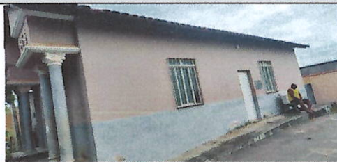
IMAGEM 2: LATERAL DA CAPELA
