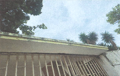
IMAGEM 5: ÁREAS SEM EMBOÇO NO TETO LOCAL: CEMITÉRIO SENHOR DO BONFIM
