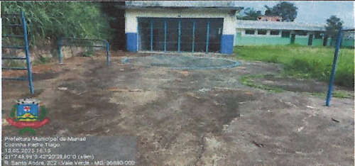
IMAGEM 6: GUARDA-CORPO COM PINTURA DANIFICADA LOCAL: PADRE TIAGO
