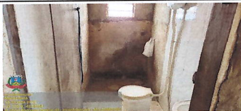
IMAGEM 5: BANHEIRO LOCAL: CASA
