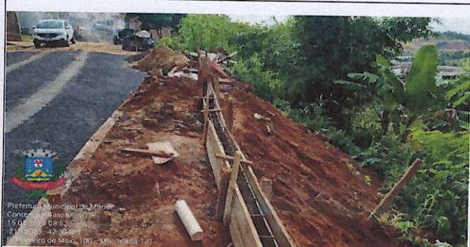
Figuras 11 e 12: Escada pública em concreto armado
