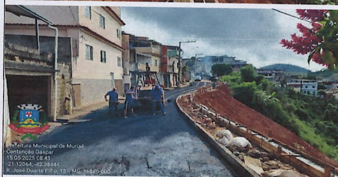
Figuras 15 e 16: Viga de banda para colúna e guarda-corpo; por intermédio utilitária
