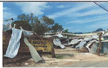
IMAGEM 4: COBERTURA DERRUBADA LOCAL: QUADRA DO INCONFIDÊNCIA
