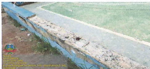
IMAGEM 5: TUBULAÇÃO REMANESCENTE NA MURETA LOCAL: QUADRA DO INCONFIDÊNCIA
