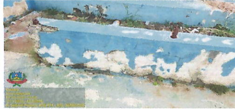
IMAGEM 6: TUBULAÇÃO REMANESCENTE NA MURETA LOCAL: QUADRA DO INCONFIDÊNCIA
