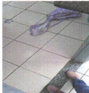
IMAGEM 8: CERAMICA SOLTA (BANHEIRO MASC. 2º PAV) LOCAL: E.M. RICARDO OLIVEIRA MORAIS DE AZEVEDO
