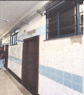
IMAGEM 11: TROCA DE REVESTIMENTO CIRCULAÇÃO. LOCAL: SETOR DE EPIDEMIOLOGIA
