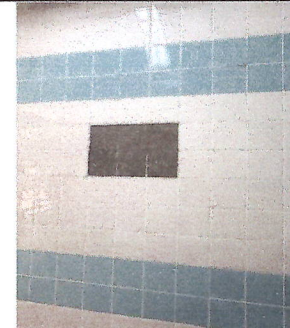
IMAGEM 13: TROCA DE REVESTIMENTO CIRCULAÇÃO. LOCAL: SETOR DE EPIDEMIOLOGIA
