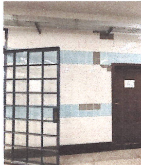
IMAGEM 6: TROCAR REVESTIMENTO DO ACESSO. LOCAL: SETOR DE EPIDEMIOLOGIA
