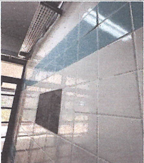
IMAGEM 9: TROCA DE REVESTIMENTO DA CIRCULAÇÃO. LOCAL: SETOR DE EPIDEMIOLOGIA
