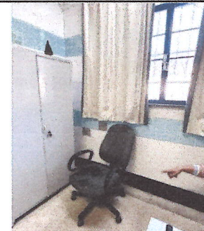
IMAGEM 12: TROCA DE REVESTIMENTO NO CONSULTÓRIO. LOCAL: SETOR DE EPIDEMIOLOGIA
