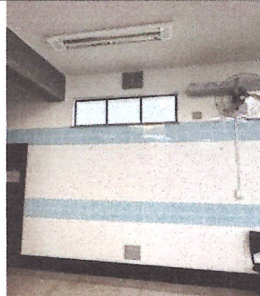
IMAGEM 8: TROCA DE REVESTIMENTO NA RECEPÇÃO. LOCAL: SETOR DE EPIDEMIOLOGIA
