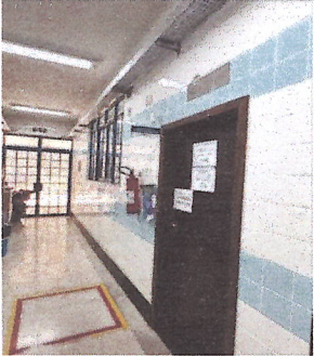
IMAGEM 7: PISO RAMP A SER DEMOLIDO LOCAL: SETOR DE EPIDEMIOLOGIA
