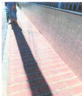
IMAGEM 2: CALÇADA A SER DEMOLIDA LOCAL: E.M. ODALEIA MORAIS DE AZEVEDO
