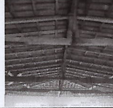
IMAGEM 6: VISTA INTERIOR DO TELHADO
