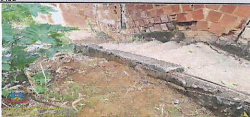
IMAGEM 6: SEM CAPTÇÃO DE ÁGUA PLUVIAL LOCAL: ESCADÃO RUA NEWTON RESENDE/SÃO CRISTÓVÃO
