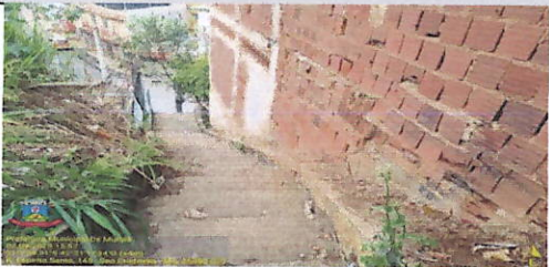
IMAGEM 3: PAREDE SEM ACABAMENTO LOCAL: ESCADÃO RUA NEWTON RESENDE/SÃO CRISTÓVÃO
