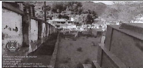
IMAGEM 4: MURO LATERAL E VEGETAÇÃO LOCAL: CEMITÉRIO ITAMURI
