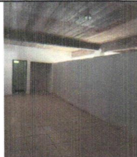
IMAGEM 2: DIVISÓRIAS EXISTENTES LOCAL: E.M. IRENE PEREIRA NUNES
