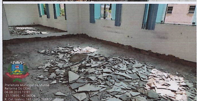
Figuras 7 e 8 - Chispeio e embuchamento de alvenaria, demolição de piso e telhado
