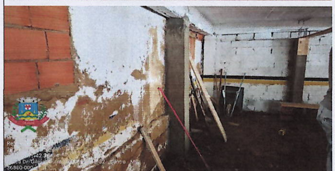
Figuras 3 e 4 - Lastro de concreto, aço da sapata, pilares concretados, fabricação e montagem das formas
