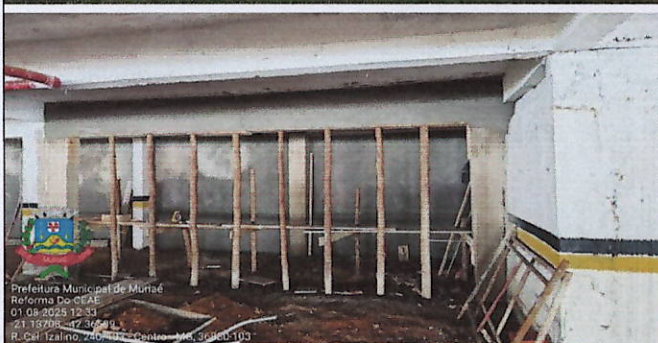
Figuras 5 e 6 - Foto de obra, encoramento da viga
