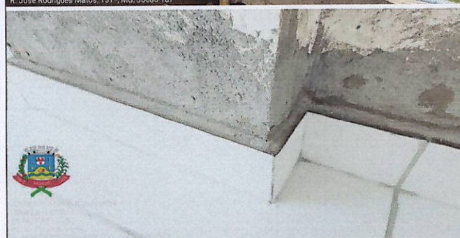
Figuras 13 e 14: Grade metálica pintada, rodapé inserido e rejuntado
