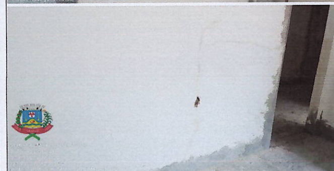
Figuras 15 e 16: Tratamento de trincas e fissuras
