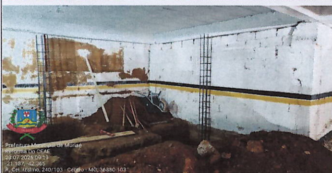
Figuras 1 e 2 - Escavação manual, remoção do apo dos sapatos e dos pilares
