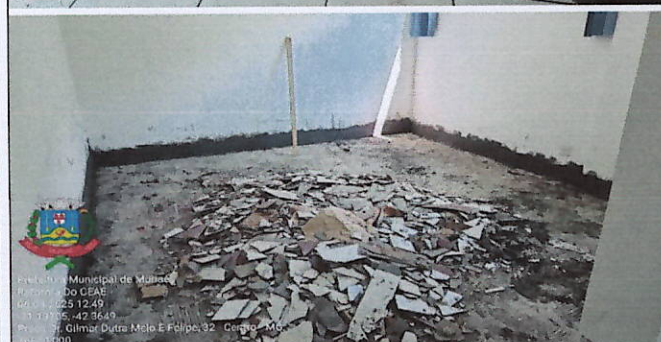
Figuras 9 e 10: Demolição de piso antigo
