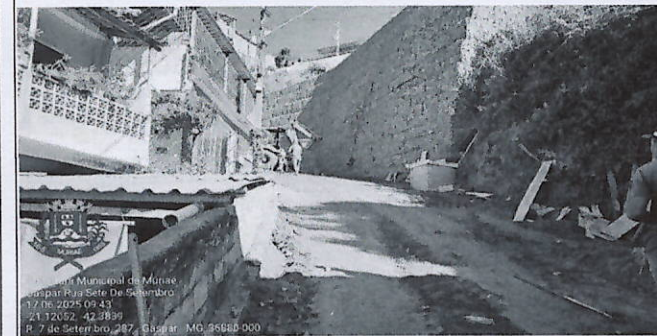
Figuras 7 e 8 - Caixas coletoras do final e início da contenção
