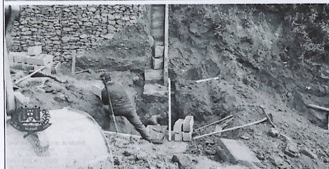
Figuras 5 e 6 - Construção de caixa coletora do final da contenção; Tubo de concreto 400mm para ligação entre caixa coletora e rede; Construção da caixa coletora do início da contenção
