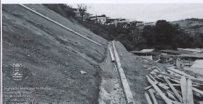
Figuras 1 e 2 - Sejetas construídas no ponto médio e na base do talude
