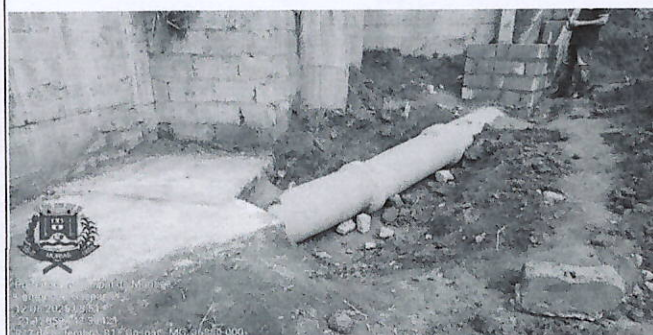
Figuras 1 e 2 - Sejetas construídas no ponto médio e na base do talude
