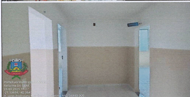
Figuras 13 e 14: Pintura esmalte e acrílica, porta de madeira reformada e pintada
