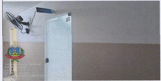
Figuras 23 e 24 - Pintura esmalte e acrílica, porta de vidro pivotante com película insulfilm jateado
