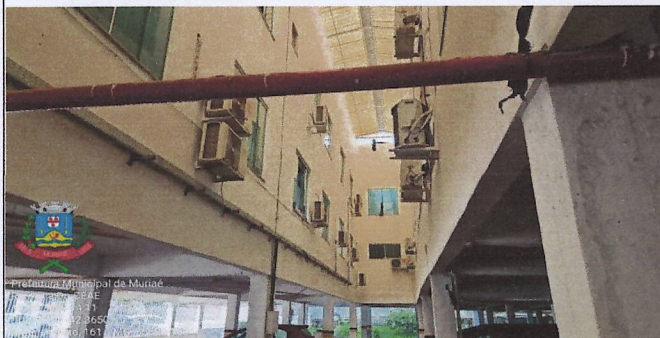
Figuras 1 e 2 - Andimes metálicos, pintura externa
