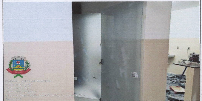
Figuras 15 e 16: Pintura esmalte e acrílica, porta de vidro pivotante
