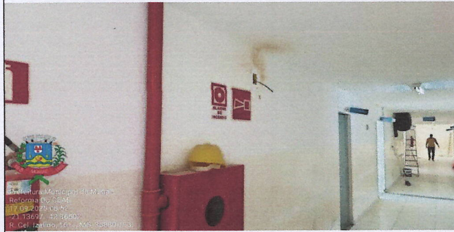
Figuras 5 e 6 - Pontos elétricos para tomadas
