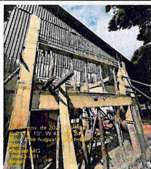
IMAGEM 3: CONSTRUÇÃO DA BASE PARA RESERVATÓRIOS LOCAL: E.M. RICARDO OLIVEIRA MORAIS DE AZEVEDO
