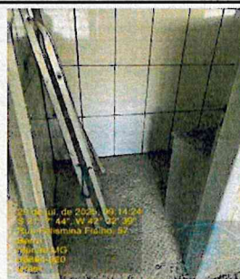
IMAGEM 2: TROCA DE PISO DANIFICADO NA DESPESA LOCAL: E.M. PROF. ODALEIA OLIVEIRA MORAIS DE AZEVEDO
