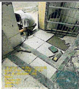
IMAGEM 1: TROCA DE PISO DANIFICADO NA ENTRADA LOCAL: E.M. PROF. ODALEIA OLIVEIRA MORAIS DE AZEVEDO
