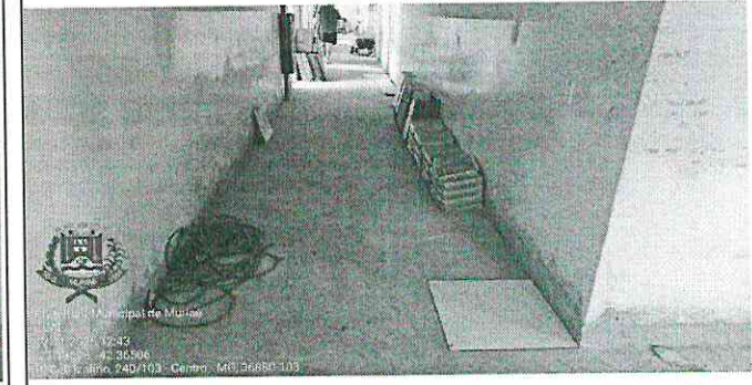
Figuras 55 e 56 - Assentamento de piso cerâmico
