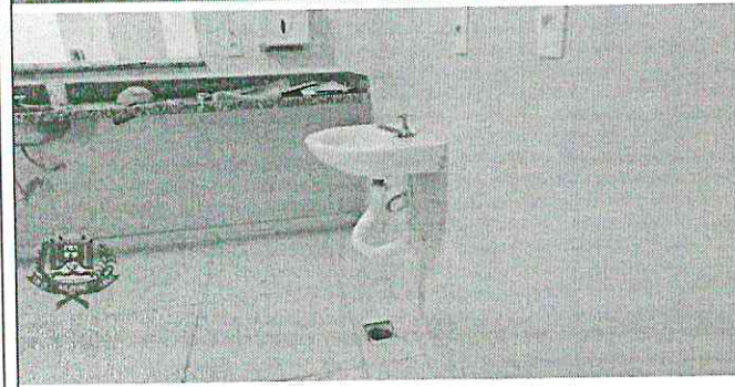
Figuras 5 e 6 - Selo de gesso e instalação de sifão
