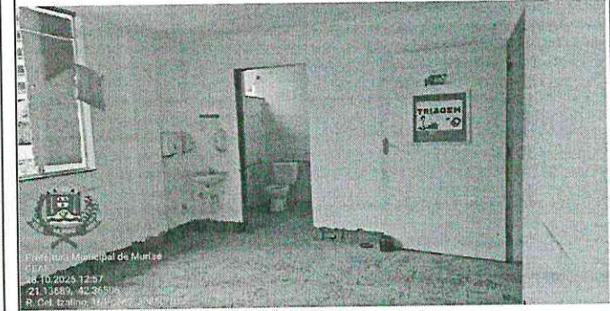
Figuras 23 e 24 - Demolição de piso cerâmico, demolição de aberturas
