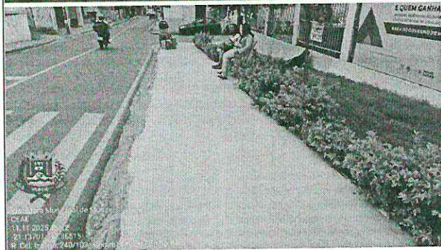
Figuras 49 e 50 - Assentamento de solapas, colada em concreto armado com juntas
