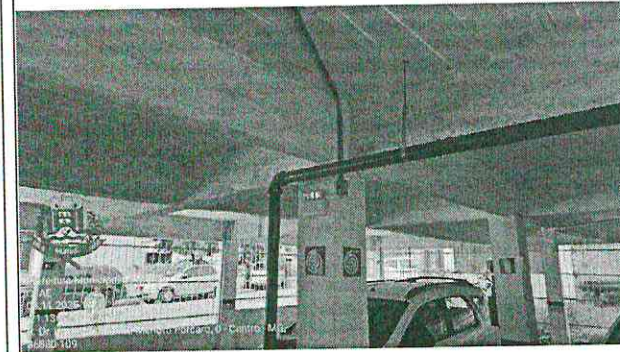
Figuras 37 e 38 - Tubulação em aço galvanizado para instalação, pintura corante em tubulação, luminária de emergência com dois eixos
