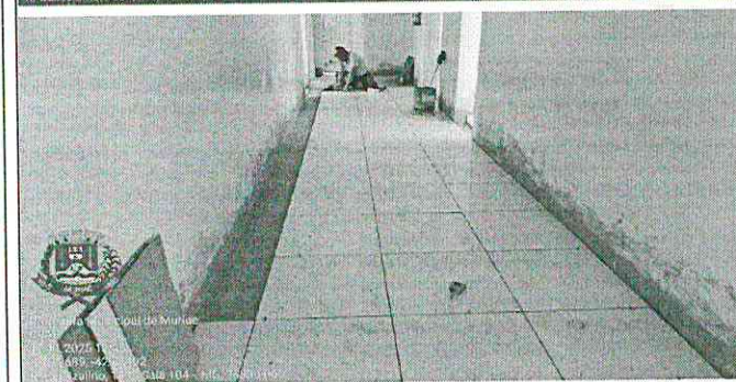
Figuras 53 e 54 - Assentamento de piso cerâmico
