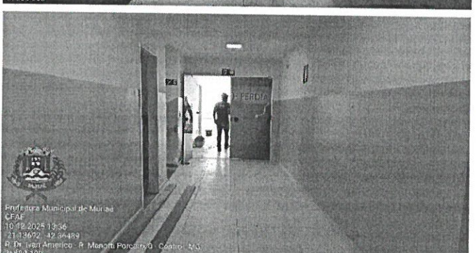
Figuras 15 e 16: Pintura de portas de madeira e sinalização de incêndio
