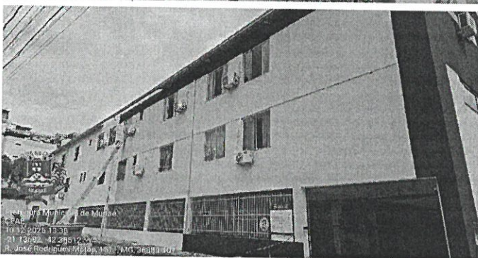
Figuras 17 e 18 - Pintura de fachada
