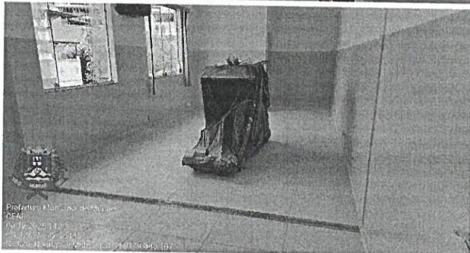
Figuras 7 e 8 - Pintura emalhe e pintura acrílica de paredes
