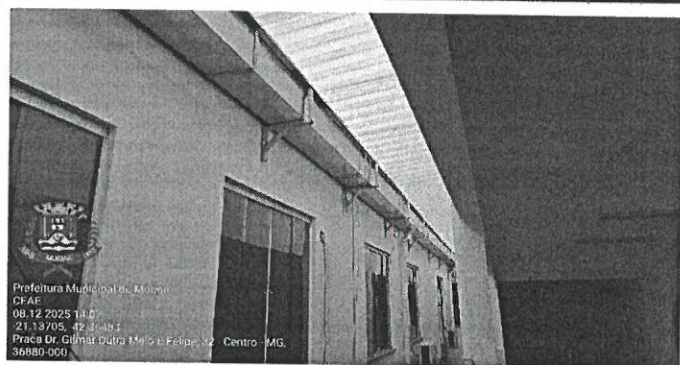
Figuras 3 e 4 - Toldo e telhamento com telhas de fibra de vidro
