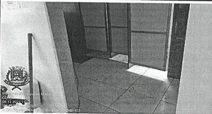
Figuras 1 e 2 - Assentamento de piso cerâmico
