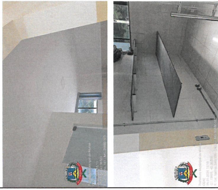
Figura 35 e 36 - Forno de granito, luminária LED de sobrepõe, heraldo e partição em granito
