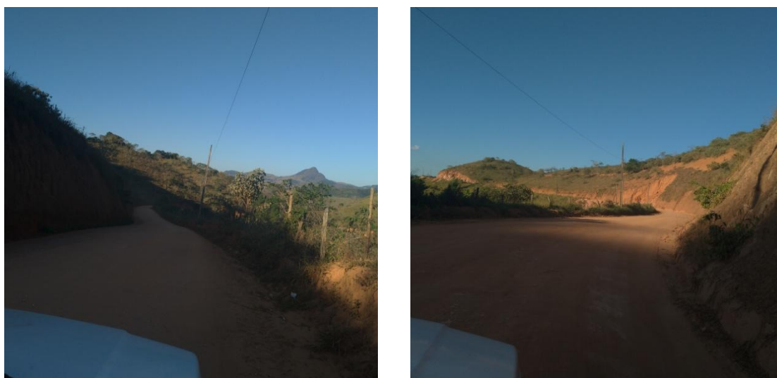
Figura 4: Fotografias do local a sofrer intervenção – vista 3 e 4.
