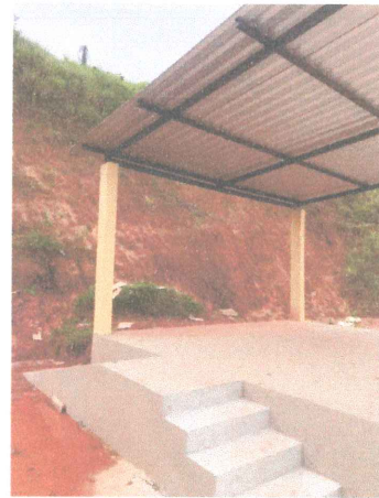
Foto 12: TELHADO, PILARES, ESCADA, PALCO
