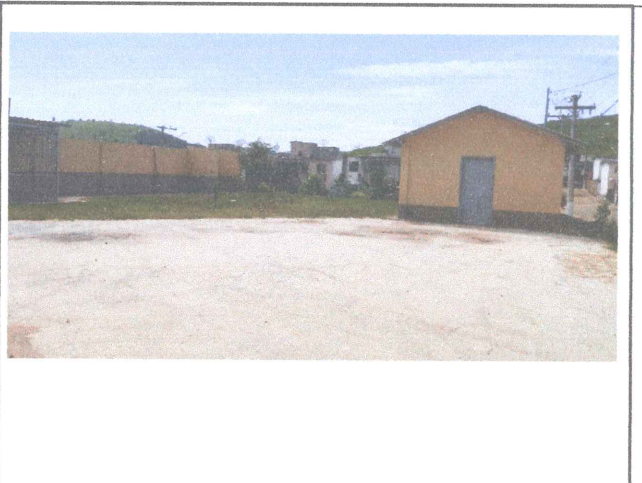
Foto 30. CONCRETAGEM PISO EXTERNO
