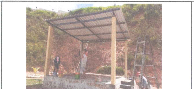
Foto 8: ESTRUTURA E TELHADO ACABADO E INICIO DE PINTURA
