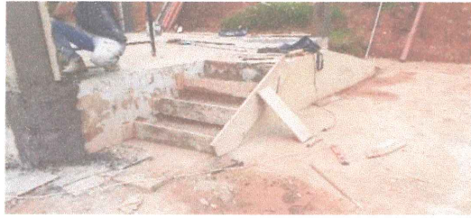
Foto 9: FORMA ESCADA E ESTRUTURA PILARES
