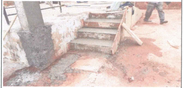
Foto 10: CONCRETAGEM ESCADA
