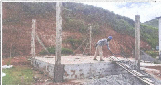
Foto 7: REMOÇÃO TELHADO, PILARES, FORMA, FUNDAÇÃO E PILARES NOVOS
